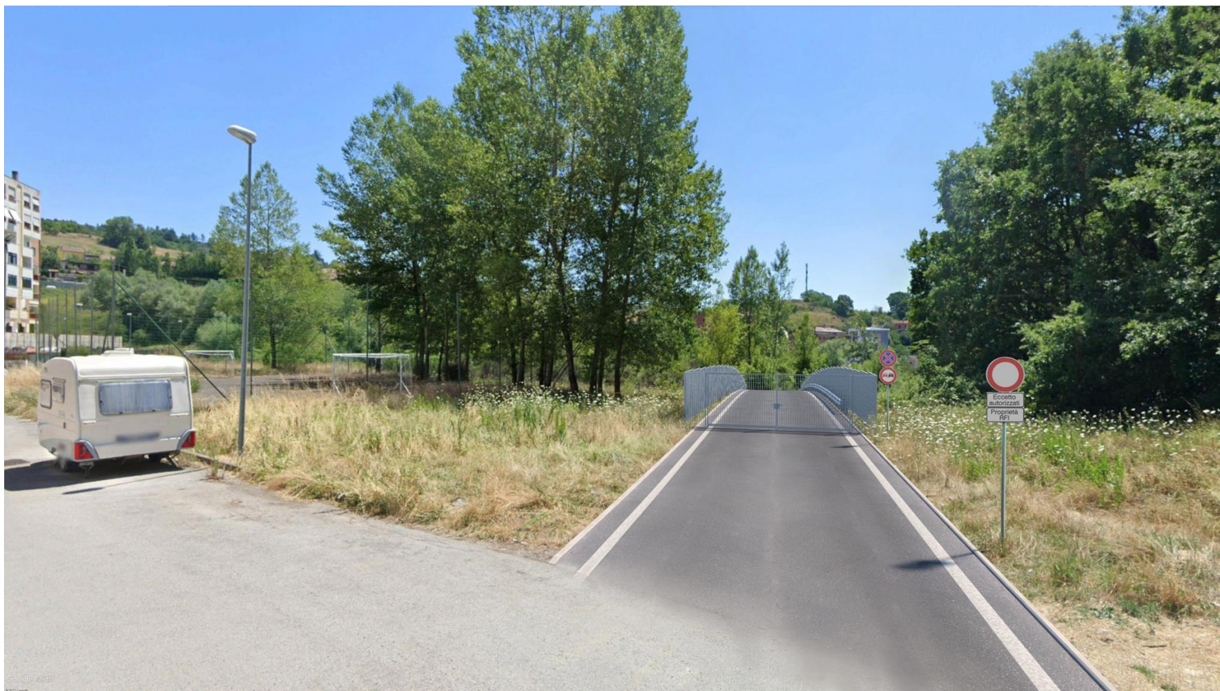
Figura 10-3 Post operam intervento NV25
