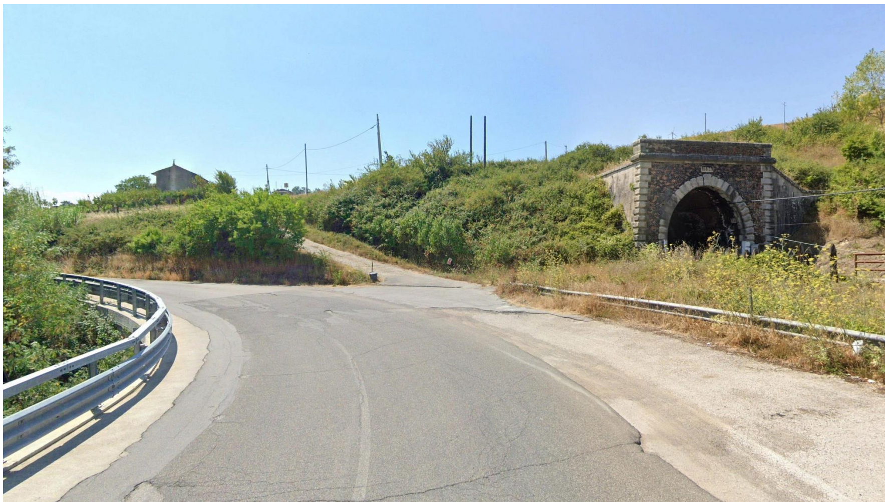
Figura 8-2 Ante operam intervento NV22
