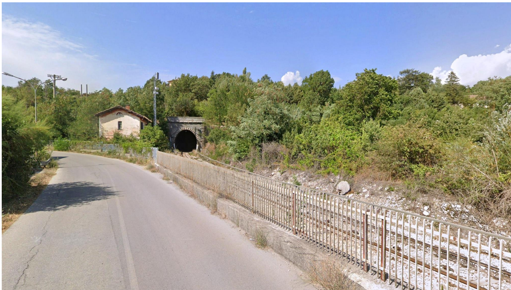
Figura 9-2 Ante operam intervento NV23
