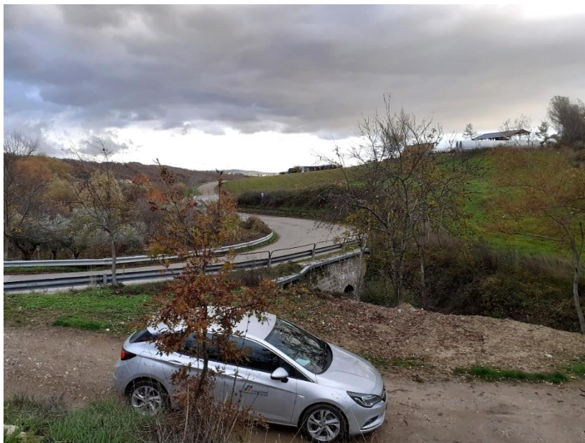
Figura 5-4 Vegetazione nei pressi della Galleria Quattrocchi
