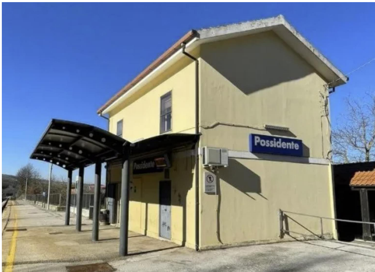
Figura 3-2 - Fabbricato viaggiatori lato Est (fonte: http://www.stazionidelmondo.it/ )
