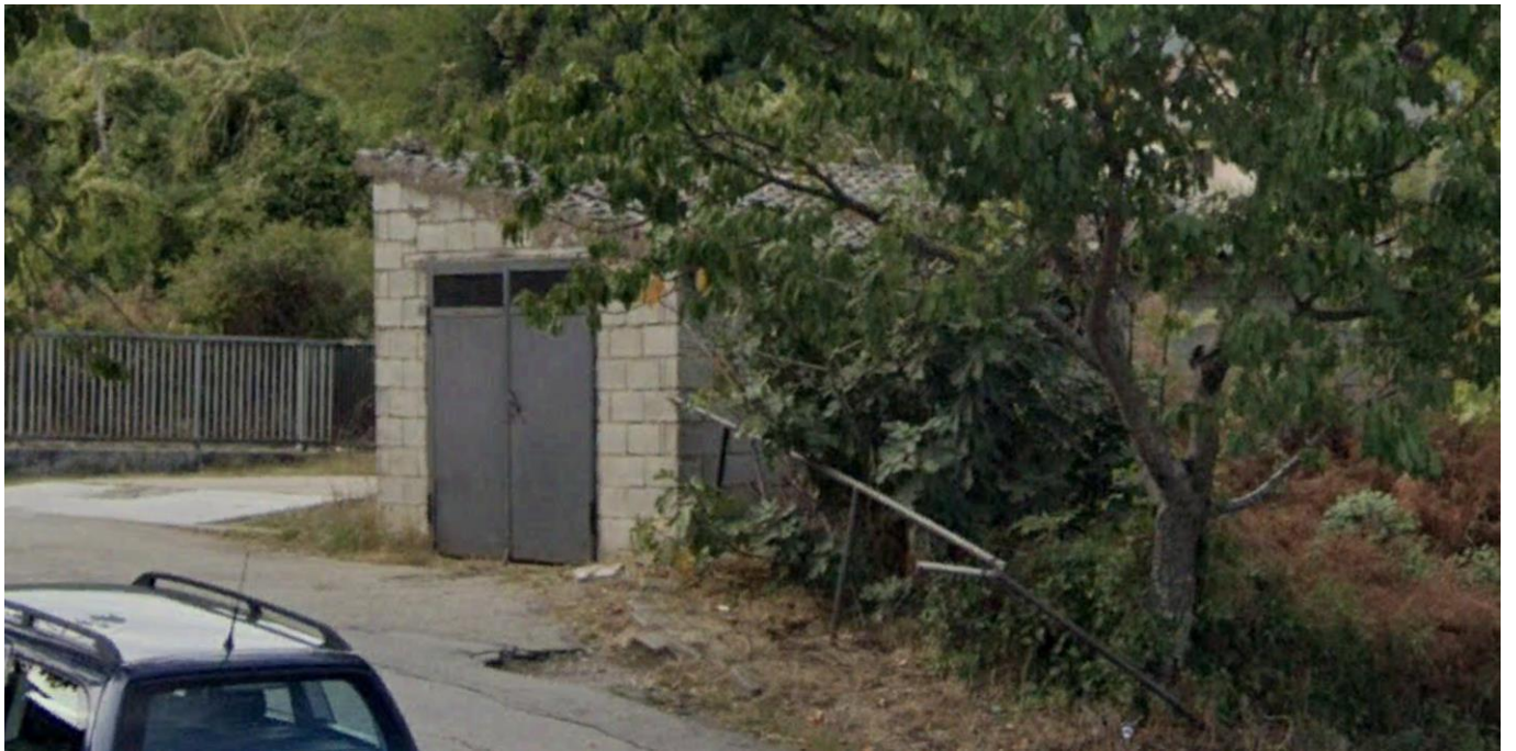
Figura 3-4 - Fabbricato ad uso magazzino
