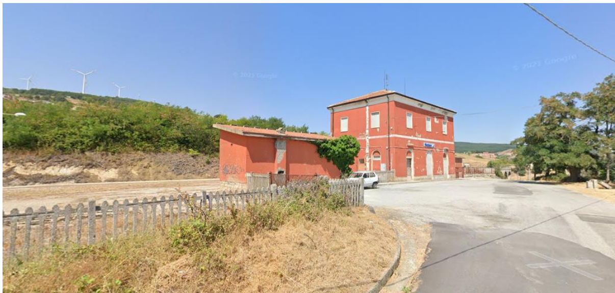
Figura 3-24 Foto della Stazione ferroviaria di Pietragalla
