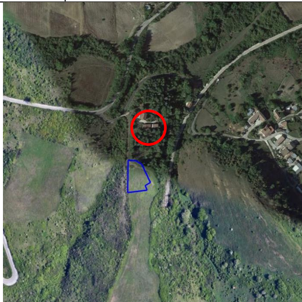
Cantiere operativo CO.07
