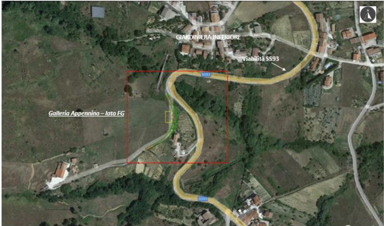
6 – Panoramica del tratto di intervento a Nord dell'imbocco della galleria Appennino - lato FG [pk100+231.35]
