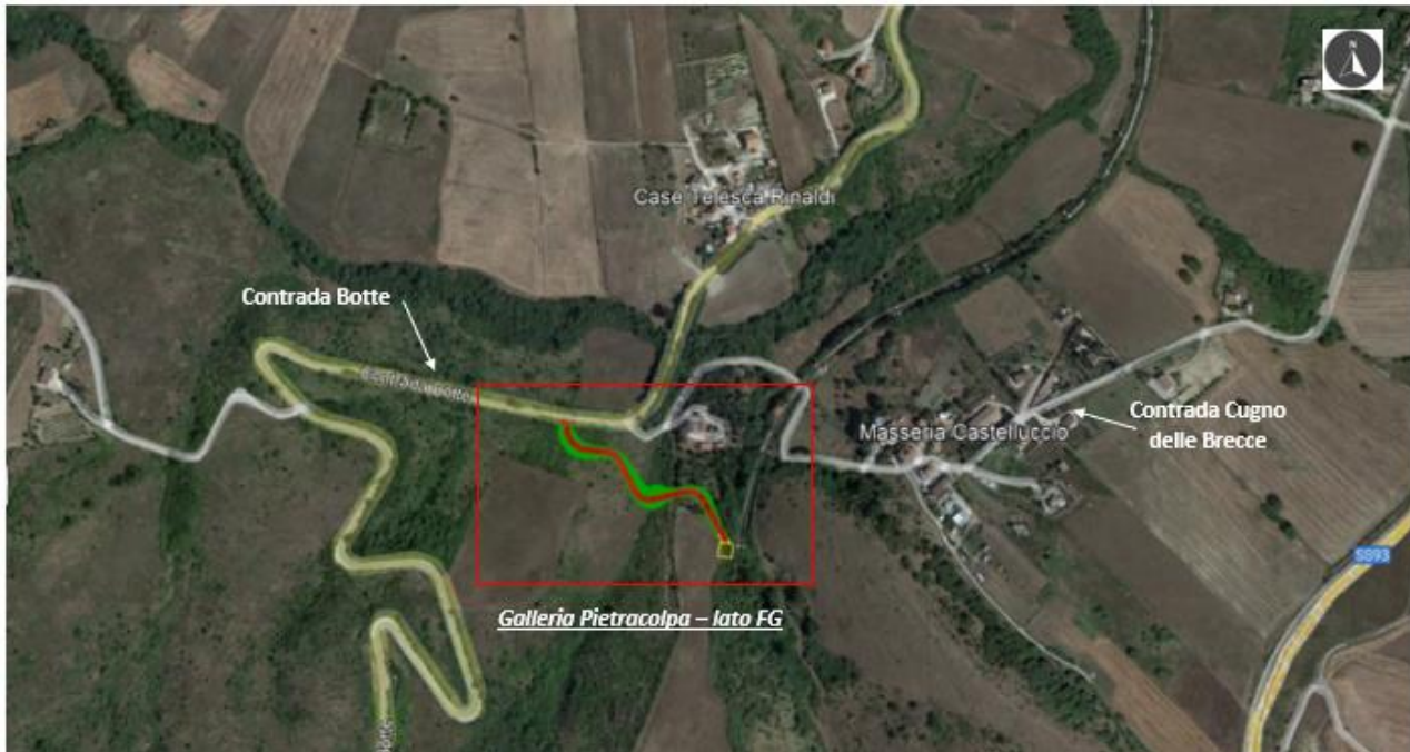
8 – Panoramica del tratto di intervento a Nord dell'imbocco della galleria Pietracolpa - lato FG [pk110+854.89]
