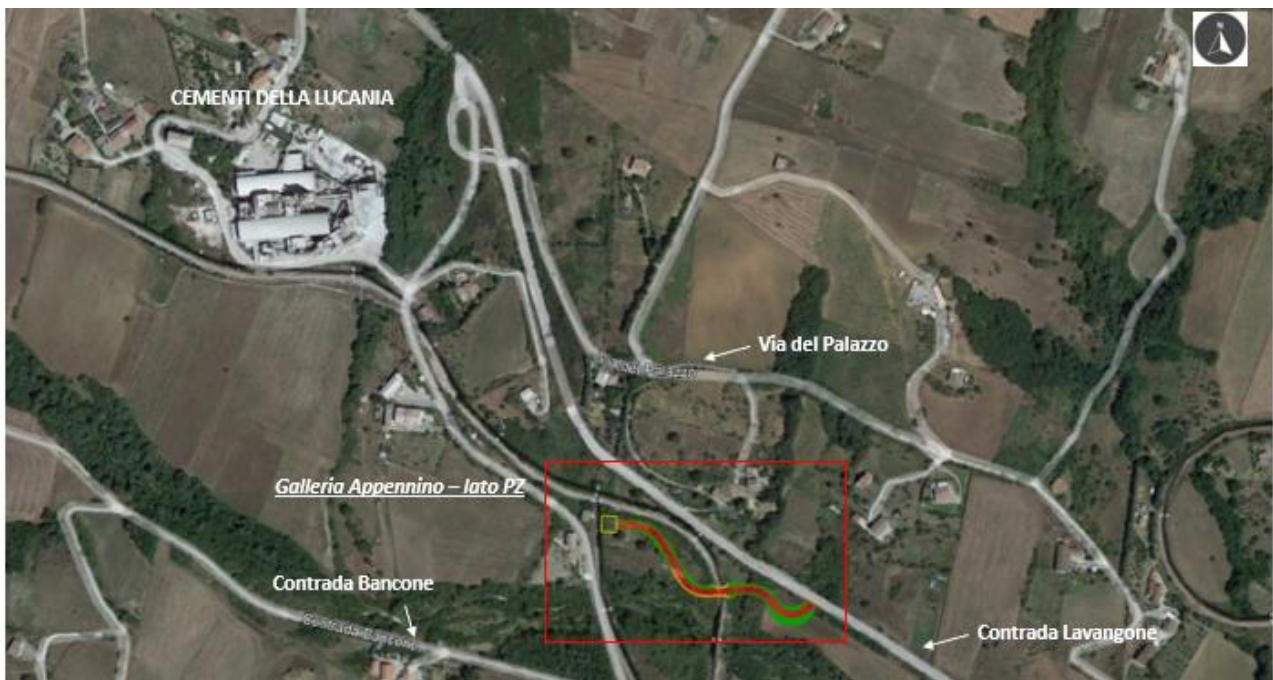
7 – Panoramica del tratto di intervento a Sud dell'imbocco della galleria Appennino - lato PZ [pk103+551.38]
