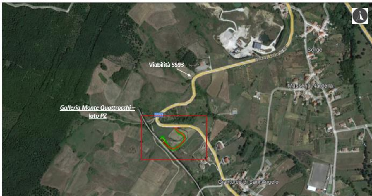
5 – Panoramica del tratto di intervento a Sud dell'imbocco della galleria Monte Quattrocchi - lato PZ [pk98+251.33]
