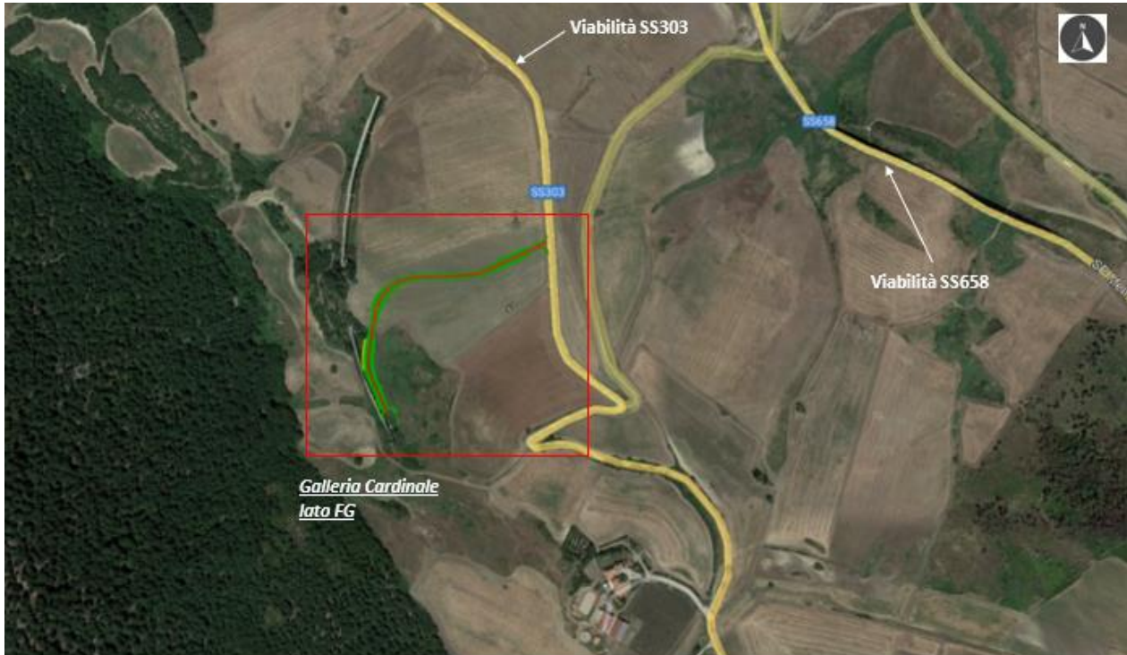
2- Panoramica del tratto di intervento a Nord dell'imbocco della galleria Cardinale - lato FG [pk60+545.50]
