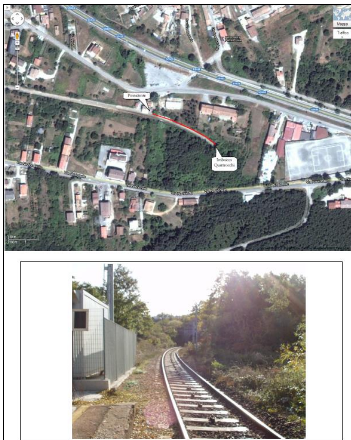
Figura 8 - Galleria Quattrocchi – Imbocco lato Foggia - Immagini da Piano di Emergenza Interno della Galleria - Lato fermata Possidente
