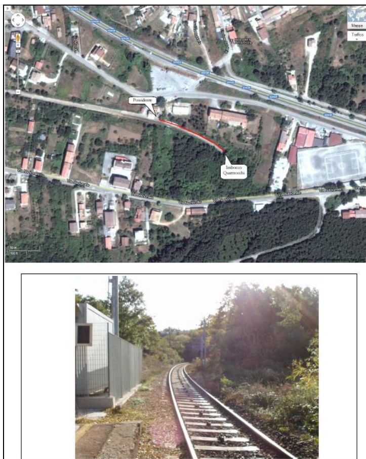
Figura 9 - Galleria Quattrocchi – Imbocco lato Foggia - Immagini da Piano di Emergenza Interno della Galleria - Lato fermata Possidente
