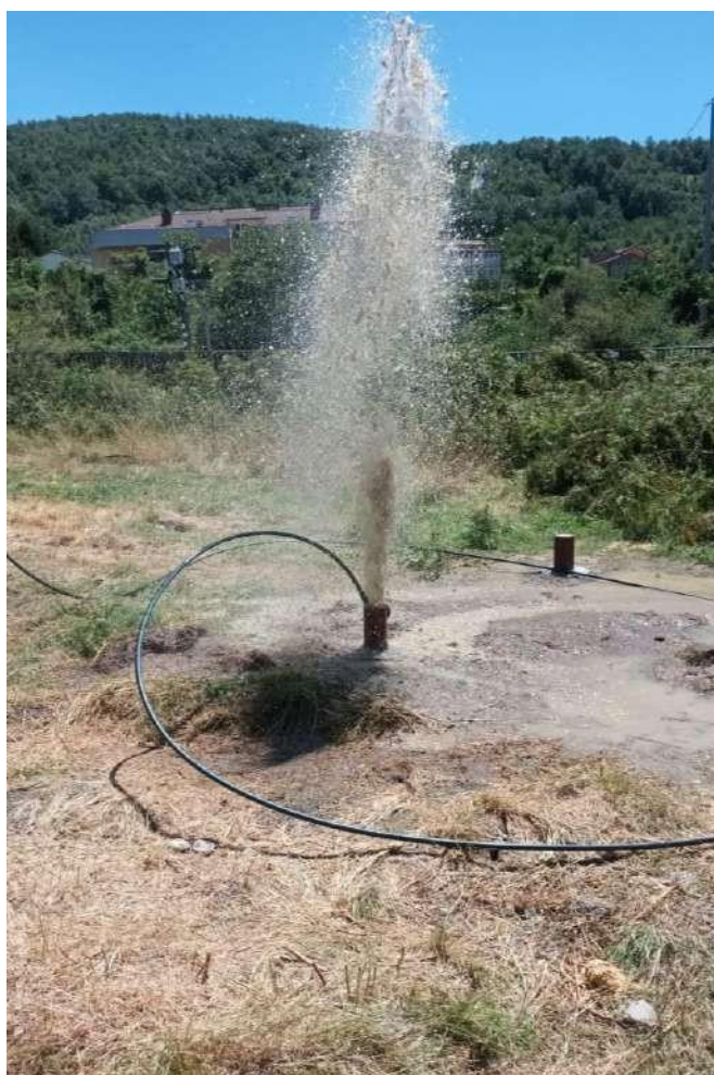
Figura 5 – Immagini rappresentative di alcune fasi delle operazione di spurgo.
