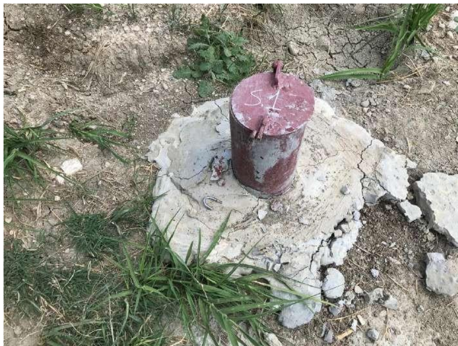
Figura 4 - Immagini rappresentative di alcune delle fasi di installazione: piezometri.
