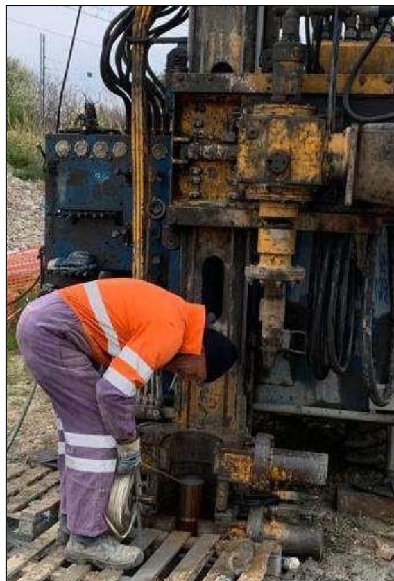
Figura 3 - Esecuzione prova di permeabilità Lefranc a carico variabile.
