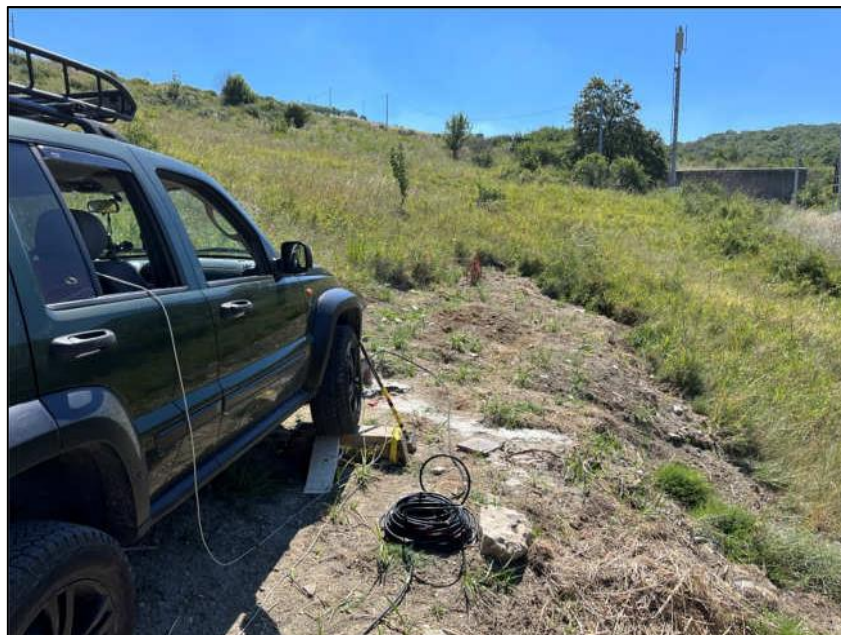
Foto 1: Esecuzione indagine Down-hole,
