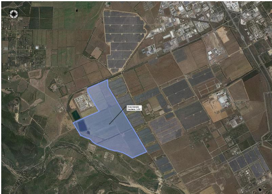
Figura 2 - Inquadramento Impianto "FV UTA" su ortofoto
