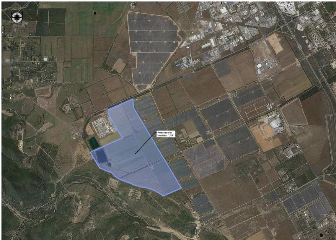
Figura 2 - Inquadramento Impianto "FV UTA" su ortofoto
