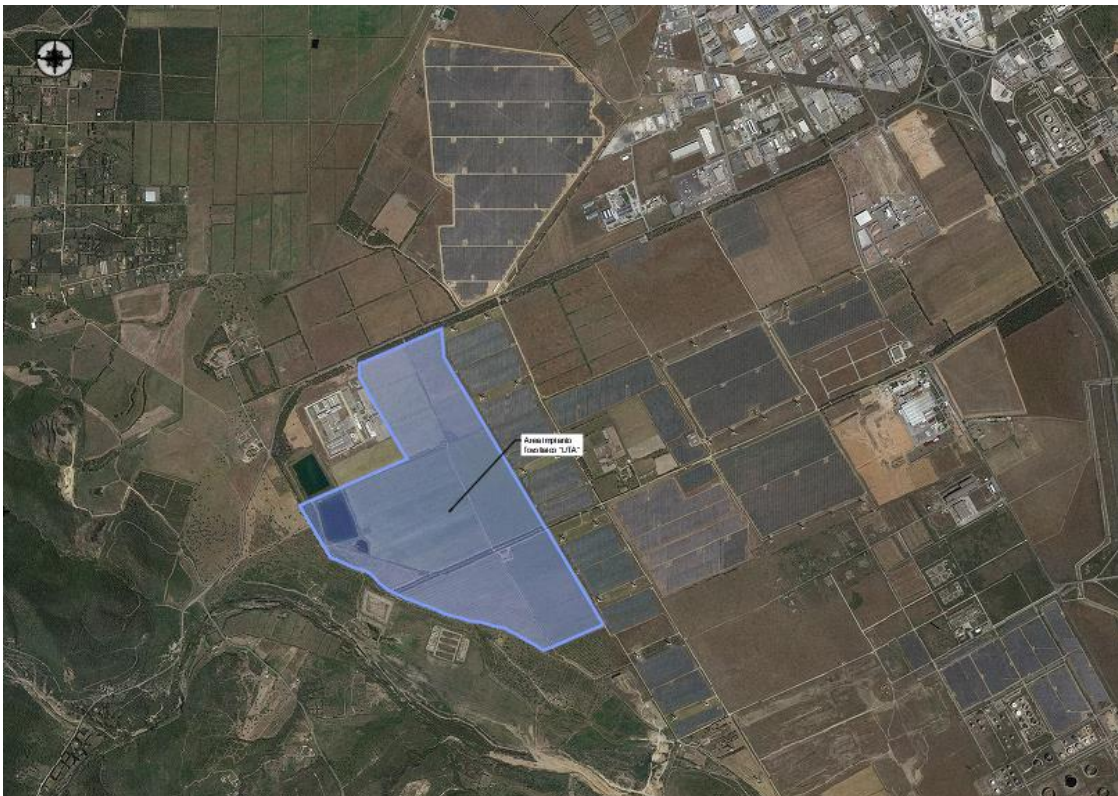
Figura 2 - Inquadramento Impianto "FV UTA" su ortofoto
