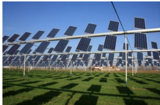
Figura 15: rete di cavi di acciaio che connette i pannelli fotovoltaici.
