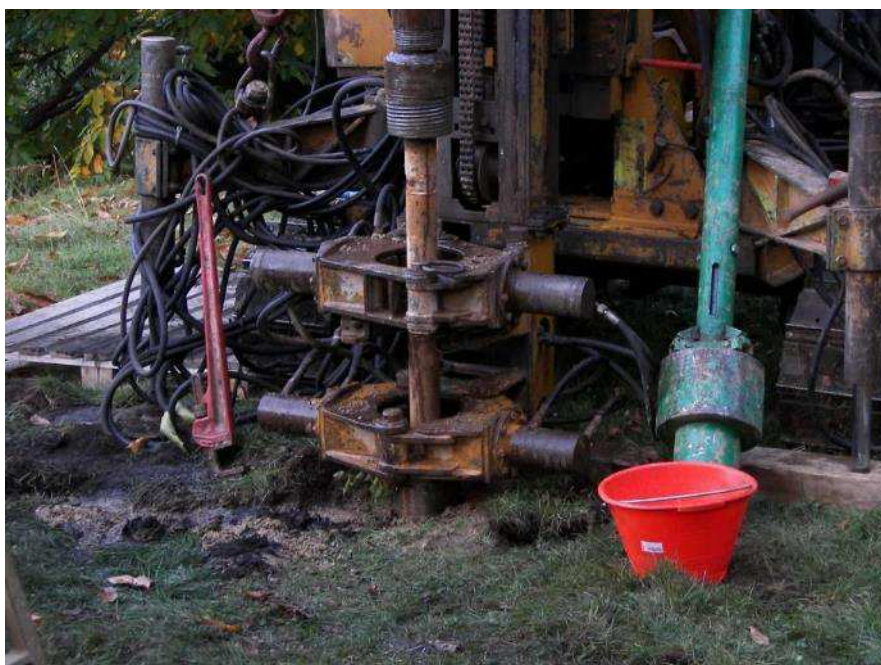
Figura 25 - Macchina operatrice per la realizzazione di micropali tubfix; sistema di scavo a rotopercolazione (fonte: Terna spa)
