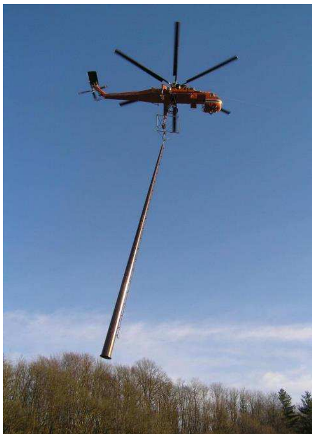
Figura 33 - Trasporto di un sostegno con elicottero Erickson (fonte: Terna spa)
