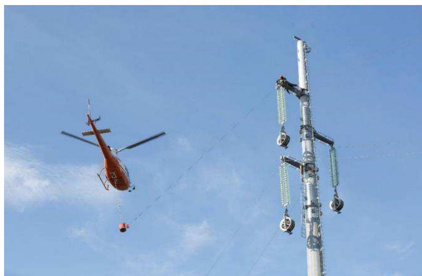
Figura 35 - Utilizzo dell'elicottero per la stesura della fune pilota. Si noti il particolare delle carrucole (fonte: Terna spa)
