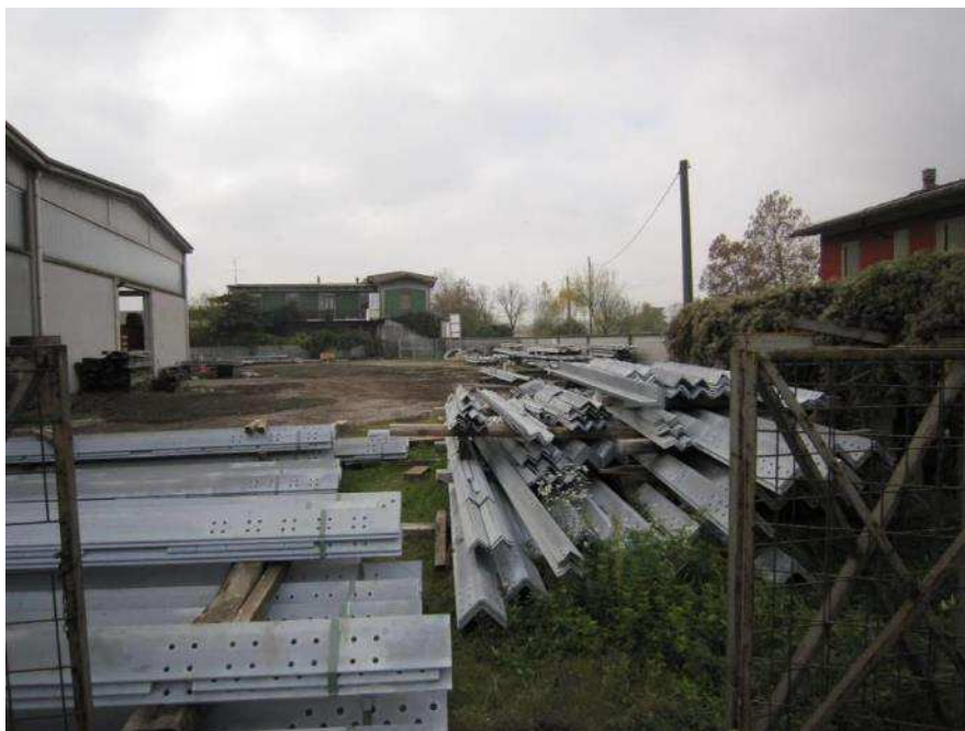
Figura 4 - Area centrale – Deposito materiale (fonte: Terna spa)
