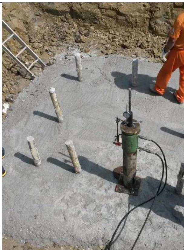
Figura 27 - Realizzazione di micropali tipo tubfix per un sostegno a traliccio; si possono osservare i 9 micropali già realizzati ed iniettati; in questa fase, prima dell'armatura e cassetatura del plinto di fondazione, si sta eseguendo una prova di tenuta del micropalo allo strappamento, al fine di verificare la corretta progettazione e realizzazione dello stesso(fonte: Terna spa) spa)
