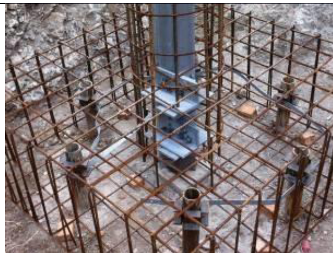
Figura 24 - Esempio di realizzazione di una fondazione su micropali tipo tubfix. Nell'immagine di destra si può notare il particolare del raccordo tra i tubolari metallici dei micropali con l'armatura del plinto di fondazione; al centro del plinto si nota il moncone del sostegno (elemento di raccordo tra il sostegno e la fondazione) il quale viene annegato nella fondazione stessa (fonte: Terna spa)
