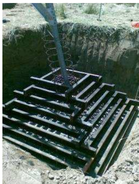
Figura 11 - Esempio di realizzazione di una fondazione a plinto con riseghe. Nell'immagine di sinistra si può osservare un disegno di progetto mentre nell'immagine di destra la fase di casseratura della fondazione (fonte: Terna spa)
