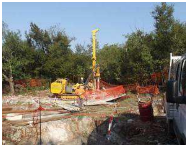
Figura 24 - Esempio di realizzazione di una fondazione su micropali tipo tubfix. Nell'immagine di destra si può notare il particolare del raccordo tra i tubolari metallici dei micropali con l'armatura del plinto di fondazione; al centro del plinto si nota il moncone del sostegno (elemento di raccordo tra il sostegno e la fondazione) il quale viene annegato nella fondazione stessa (fonte: Terna spa)
