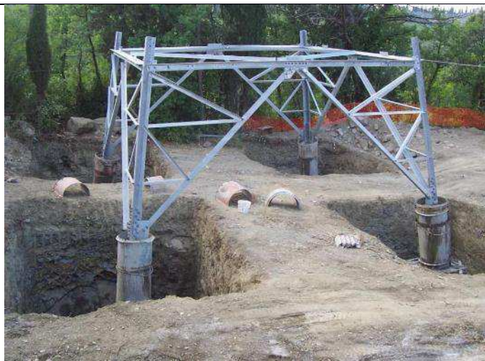
Figura 14 - Realizzazione di fondazioni superficiali tipo CR per un sostegno a traliccio. Nell'immagine si possono osservare le quattro buche, la base del sostegno collegata alla fondazione tramite i "monconi" ed i casseri utilizzati per i quattro colonnini (fonte: Terna spa)
