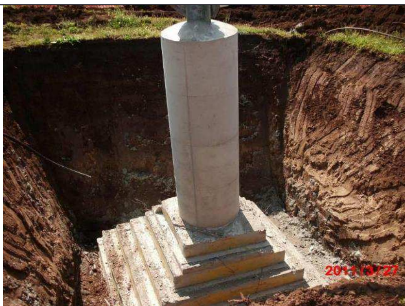
Figura 13 - Realizzazione di fondazioni superficiali tipo CR per un sostegno a traliccio. Nell'immagine si può osservare una fondazione CR appena "scasserata". Si possono distinguere facilmente la parte inferiore a parallelepipedo, i tronchi piramidali ed il colonnino di raccordo con la "base" del sostegno (fonte: Terna spa)
