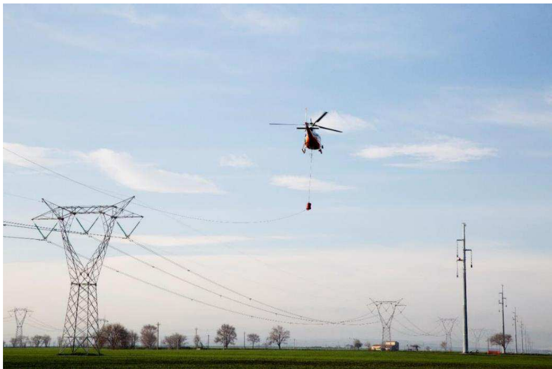
Figura 34 - Utilizzo dell'elicottero per la stesura della fune pilota (fonte: Terna spa)
