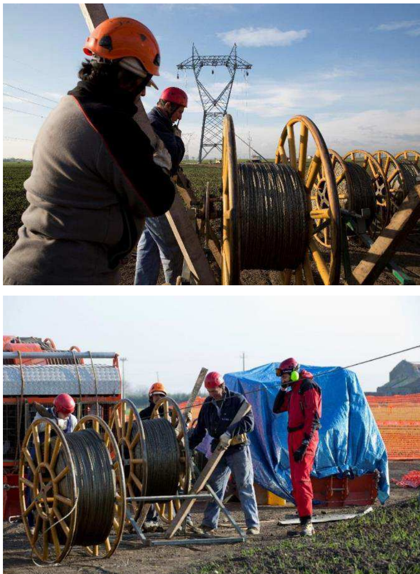
Figura 36 - Fasi di tesatura della linea elettrica (fonte: Terna spa)
