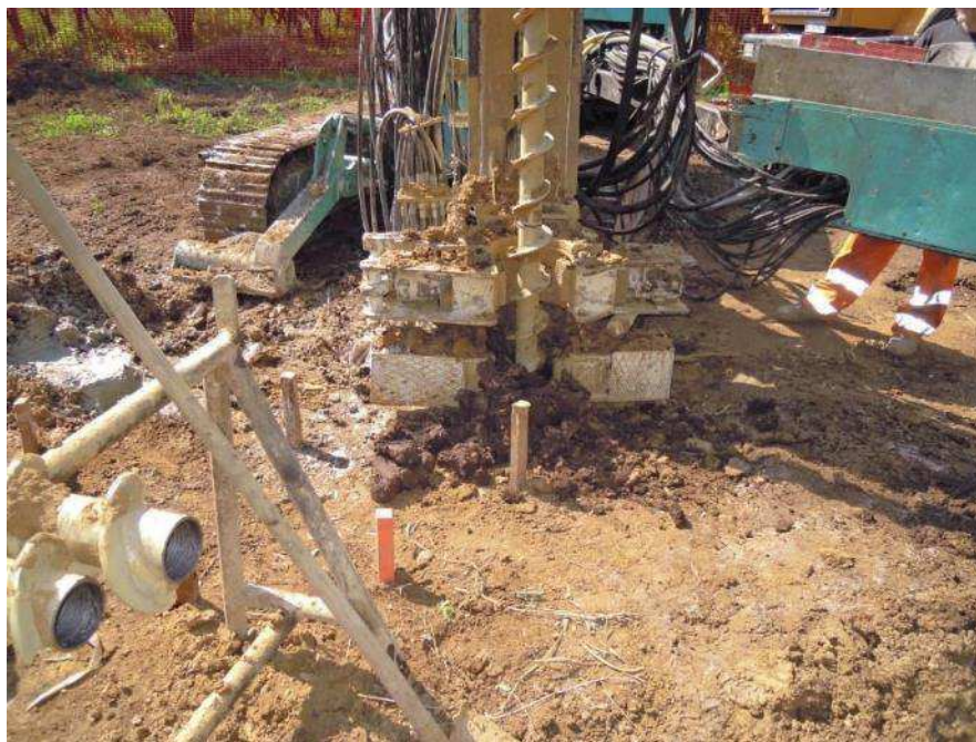
Figura 26 - Macchina operatrice per la realizzazione di micropali tubfix; sistema di scavo mediante trivella elicoidale (fonte: Terna spa)
