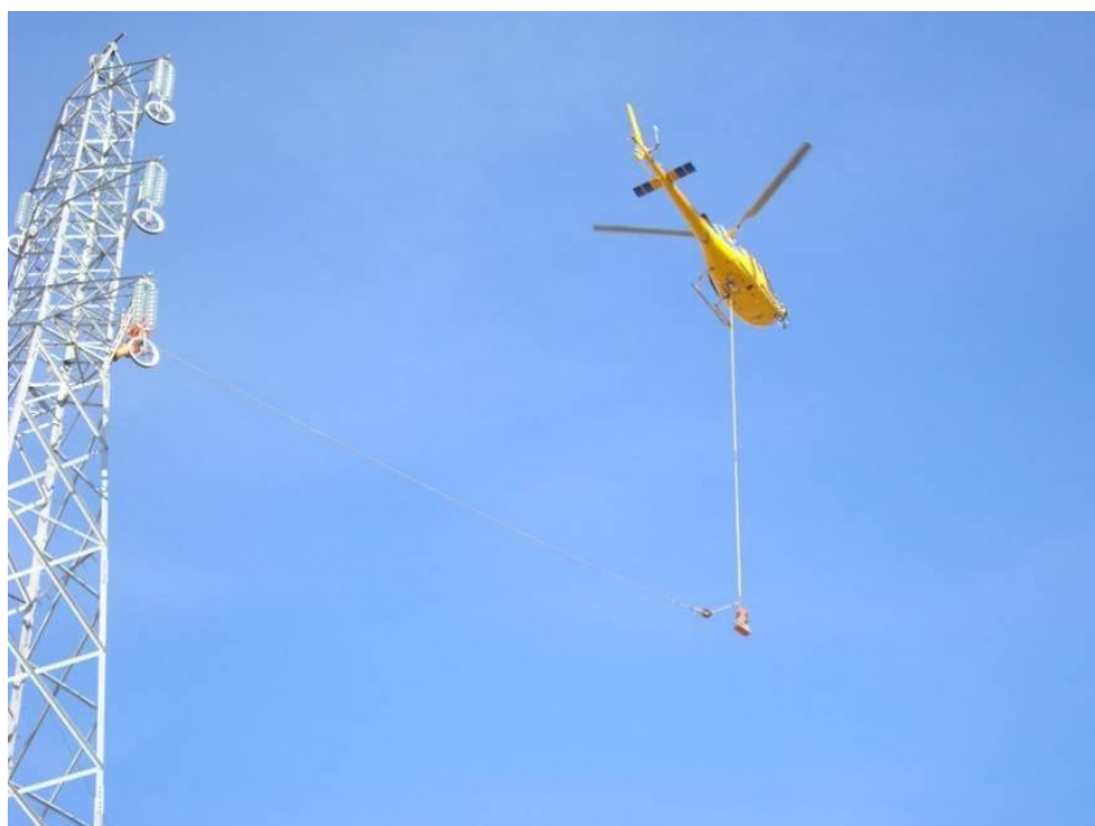
Figura 4.5.13 – Esempio di utilizzo dell'elicottero per la stesura della corda pilota
