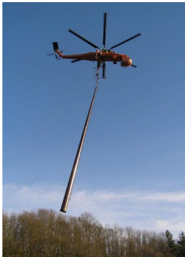
Figura 4.5.12 - Trasporto di un sostegno con elicottero Erickson (fonte: Terna spa)
