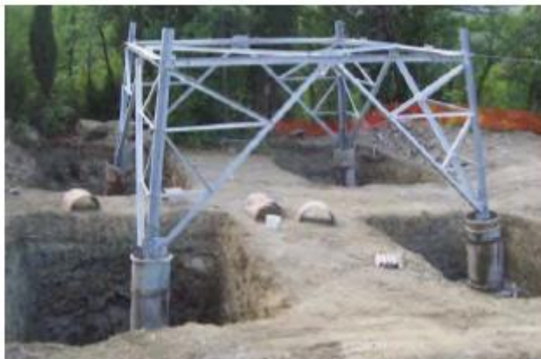
Figura 4.5.7 – Realizzazione di fondazioni superficiali tipo CR per sostegno a traliccio. Si possono osservare le quattro buche, la base del sostegno collegata alla fondazione tramite i “monconi” ed i casseri utilizzati per i quattro “colonnini”
