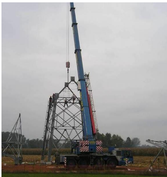
Figura 4.5.10 – Esempio di montaggio sostegno mediante l'ausilio di autogrù
