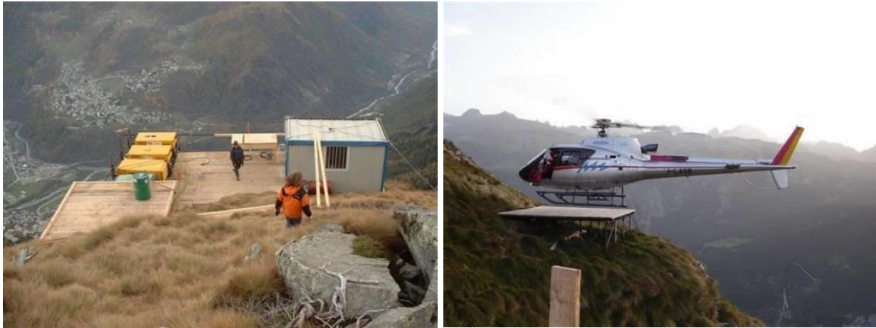
Figura 4.5.11 - Esempi di micro - cantieri in quota (fonte: Terna spa)
