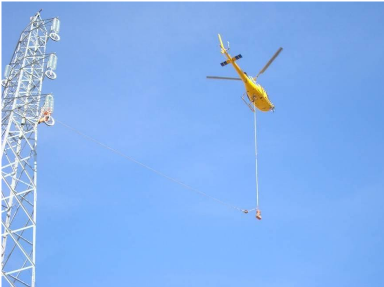
Figura 2.5.9 – Esempio di utilizzo dell’elicottero per la stesura della corda pilota
