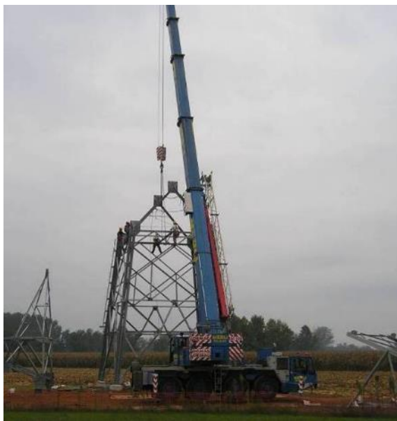
Figura 2.5.8 – Esempio di montaggio sostegno mediante l'ausilio di autogrù
