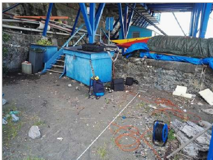
Foto 15: stesa sismica a rifrazione .
