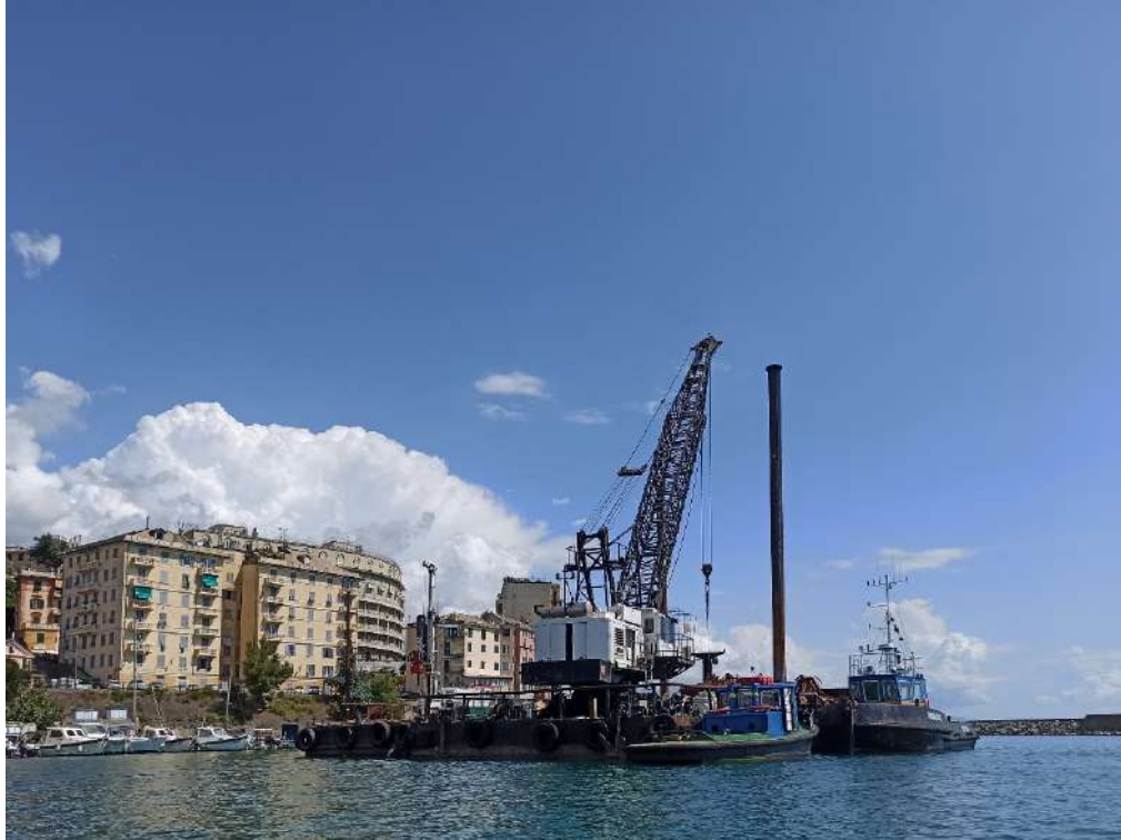
Postazione sondaggio S4
