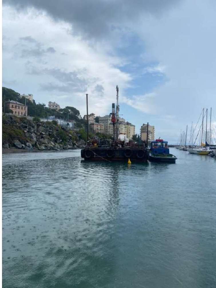
Postazione sondaggio S3
