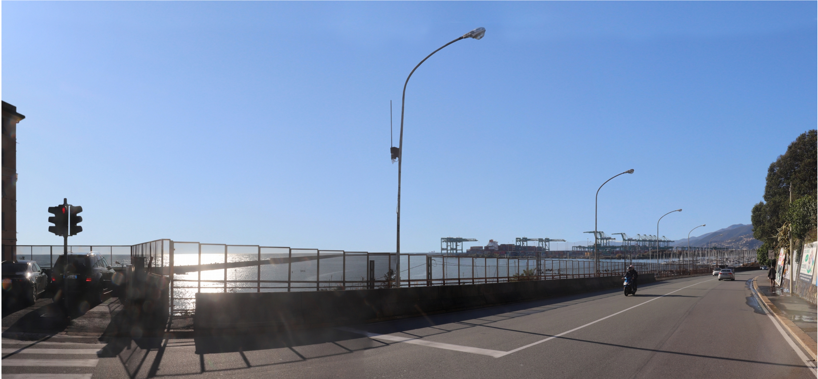
Foto 5: Panoramica dall'imbocco di via Caldesi
