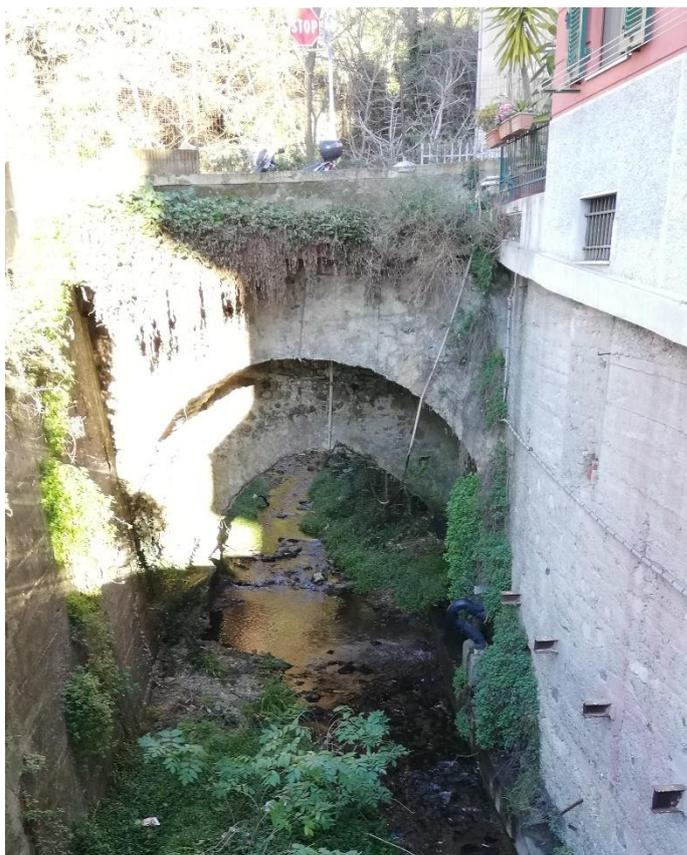
Figura 18 – Attraversamento di via Caldesi – Pontino ad arco con doppio abbassamento dell'intradosso - SEZ.8/9
