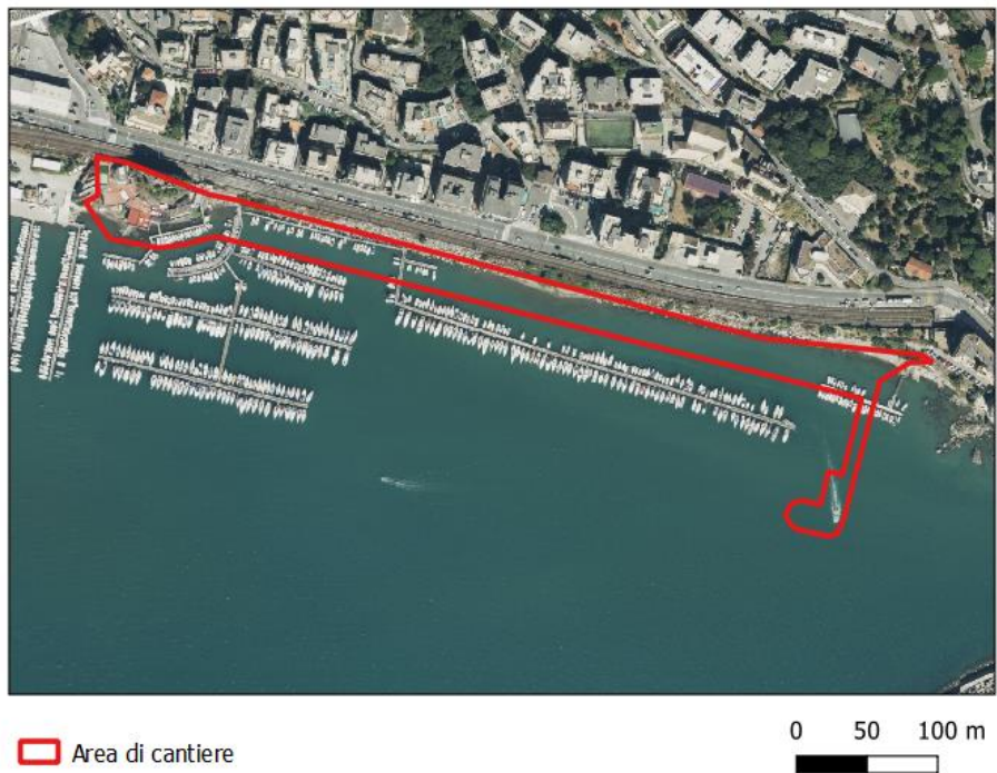
Figura 113 localizzazione dell'area di cantiere.
