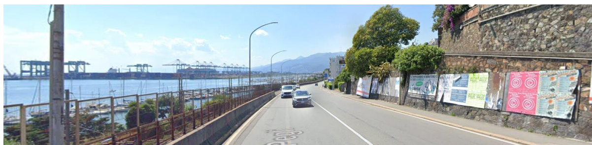
Figura 107 Area di intervento dalla via Aurelia (da est a ovest)
