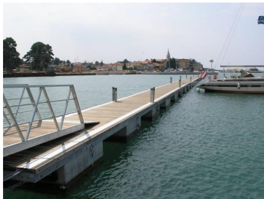
Figura 41 Esempi di pontile modulare con galleggianti in calcestruzzo
