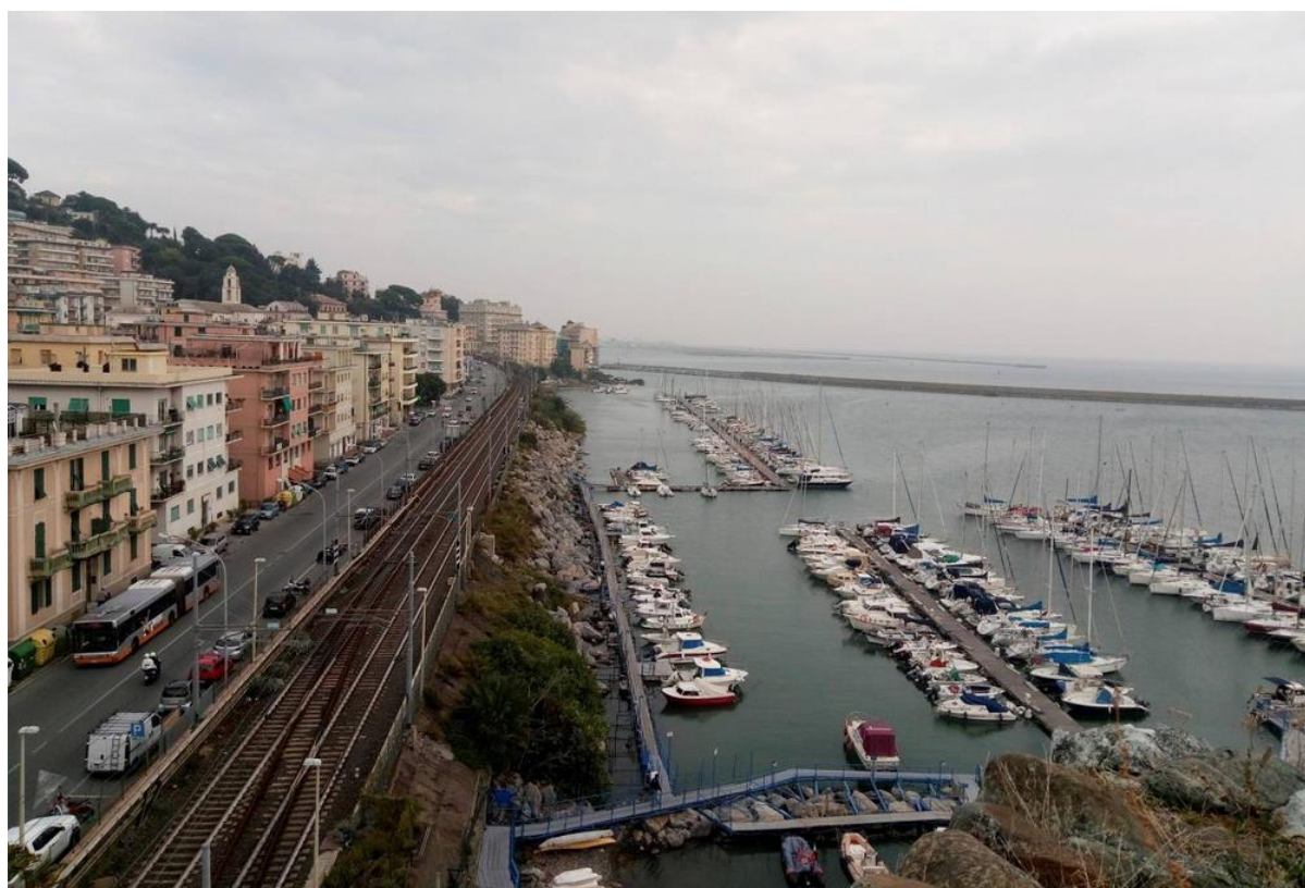
Figura 23 – Il paraggio, vista dalla rocca del Castelluccio verso il Capo del Risveglio. In primo piano la massicciata ferroviaria e la via Aurelia che separano l'abitato dal mare (Elaborato di progetto D-DG-PRD02-0 "Relazione generale")
