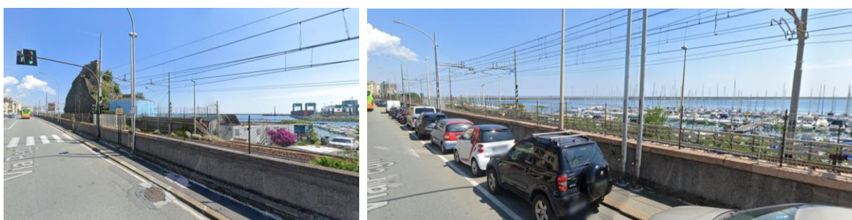
Figura 106 Area di intervento dalla via Aurelia (da ovest ad est)
