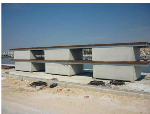
Figura 41 Esempi di pontile modulare con galleggianti in calcestruzzo
