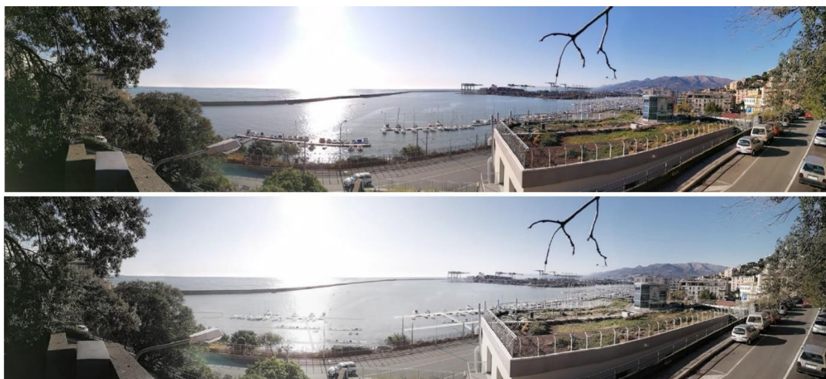
Figura 24 Vista dal giardino di Villa Banfi prima e dopo l'intervento (Elaborato di progetto "D-AR-PR-049-0")
