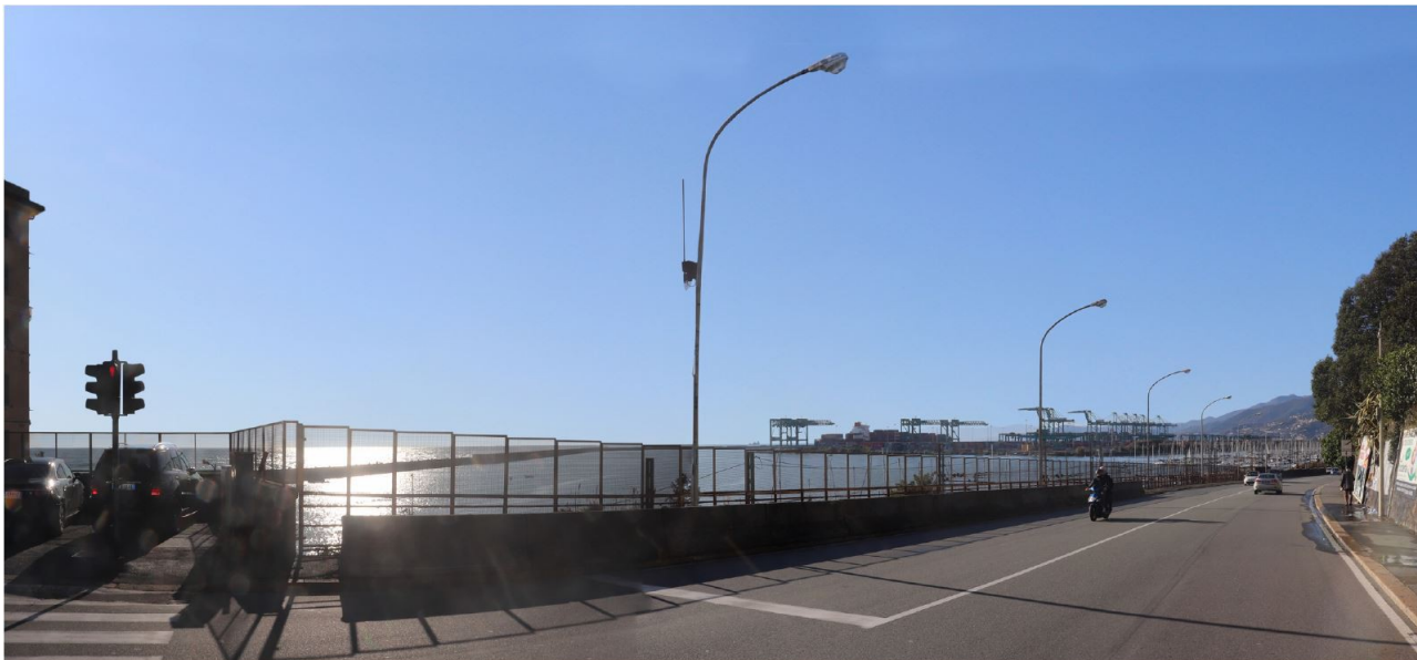
Foto 4: Panoramica dalla Via Aurelia nei pressi dell'imbocco di via Caldesi
