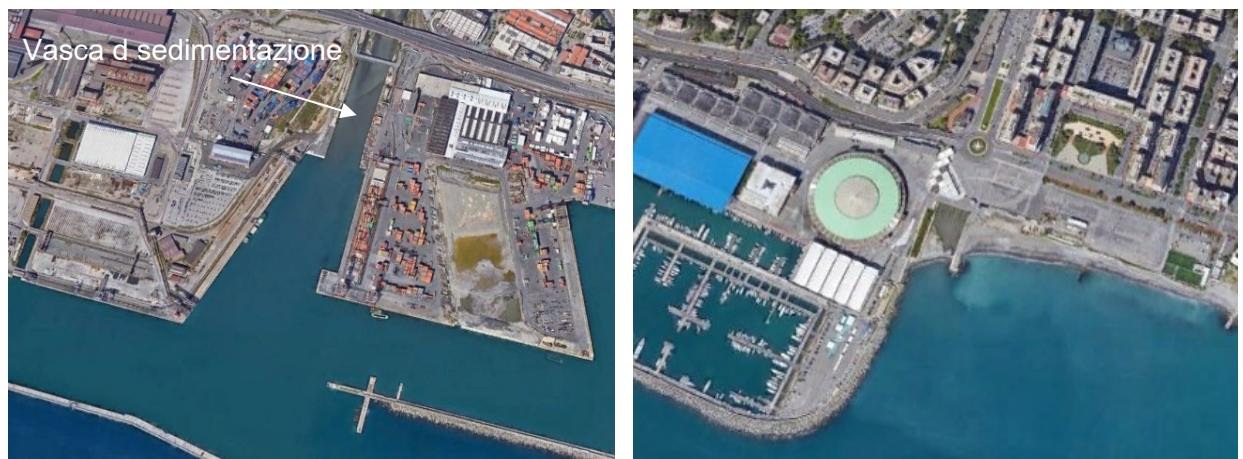
FIGURA 2-1. OPERE DI FOCE DEI TORRENTI POLCEVERA (SINISTRA) E BISAGNO (DESTRA)
