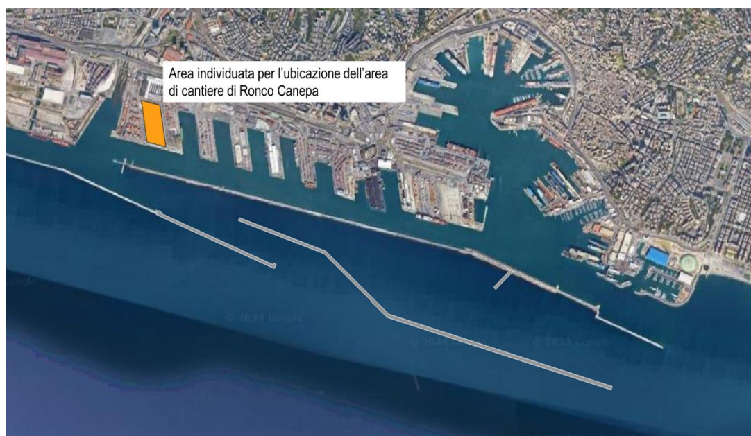
Figura 2-3: In giallo area di cantiere di Ronco Canepa
