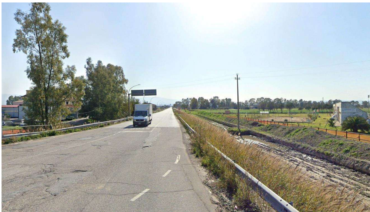
Figura 4 – Vista da nord lungo SS106 Ionica, ante operam , da Relazione paesaggistica
