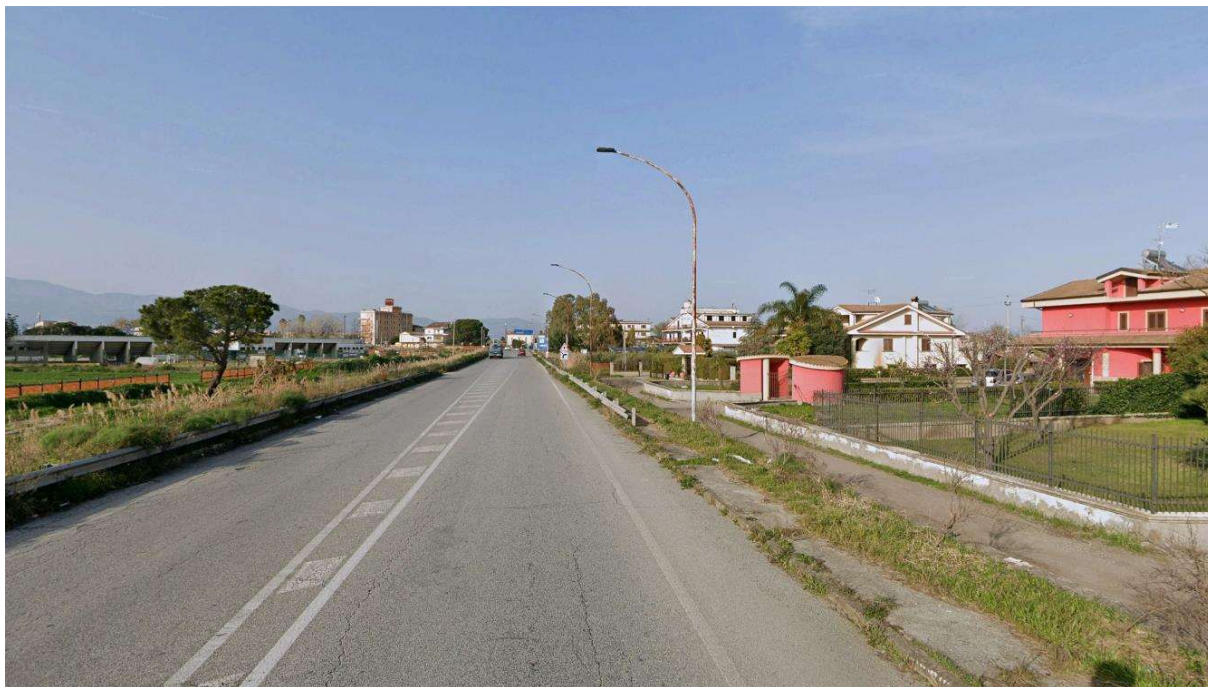
Figura 2 – Vista da sud lungo SS106 Isonica, ante operam , da Relazione paesaggistica
