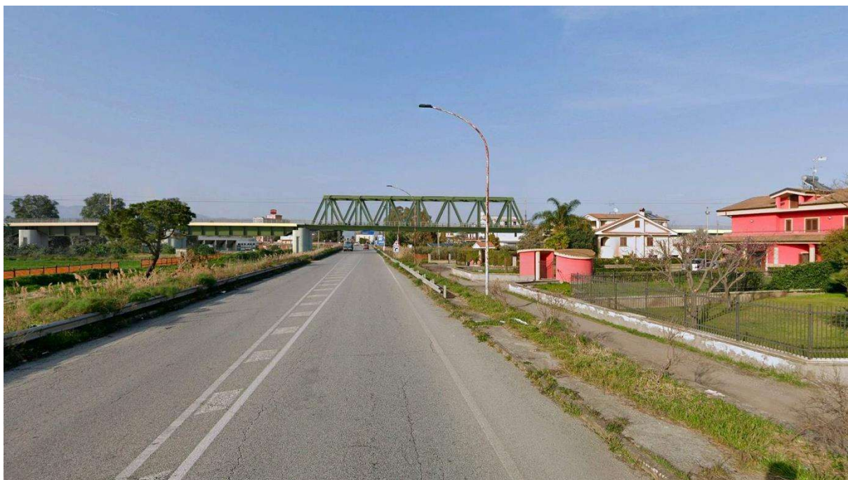
Figura 3 – Vista da sud lungo SS106 Isonica, post operam , da Relazione paesaggistica
