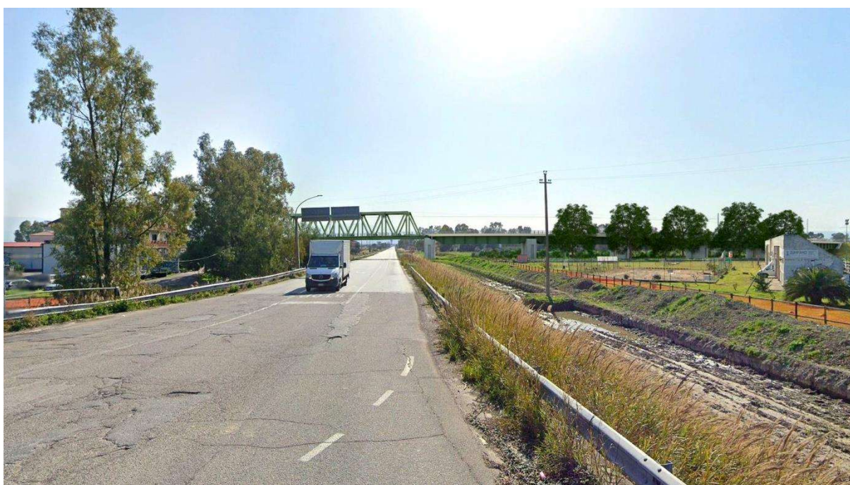
Figura 5 – Vista da nord lungo SS106 Ionica, post operam , da Relazione paesaggistica
