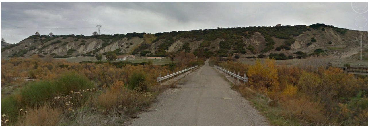
Figura 7: Vista da sud del Ponte della Salandrella.
