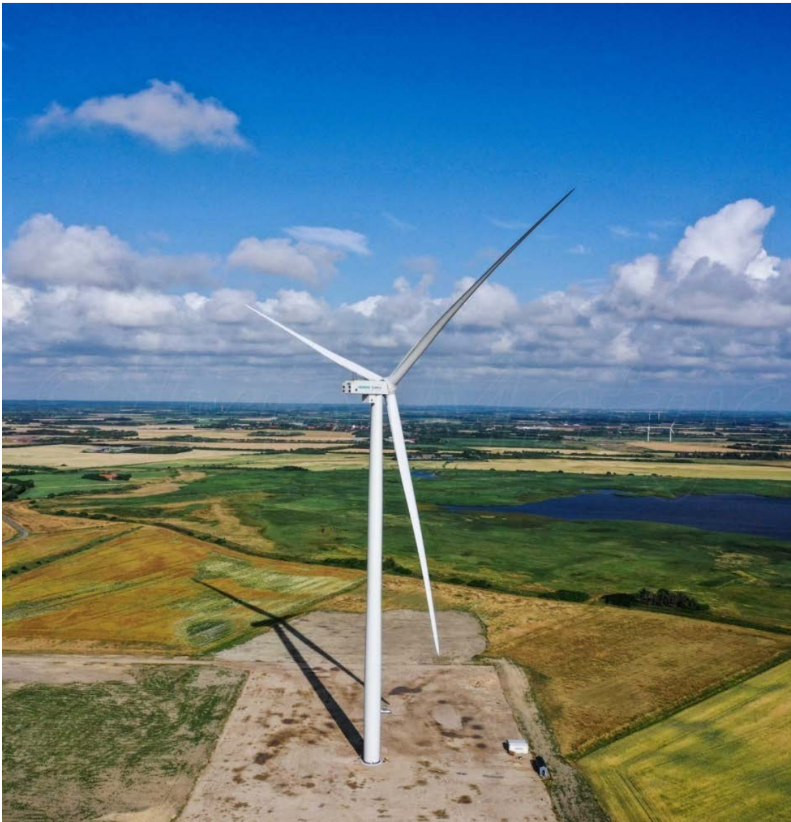
Figura 18: Turbina eolica Siemens Gamesa SG 6.2 - 170 con diametro rotore di 170 m ed altezza al mozzo di 115 m
