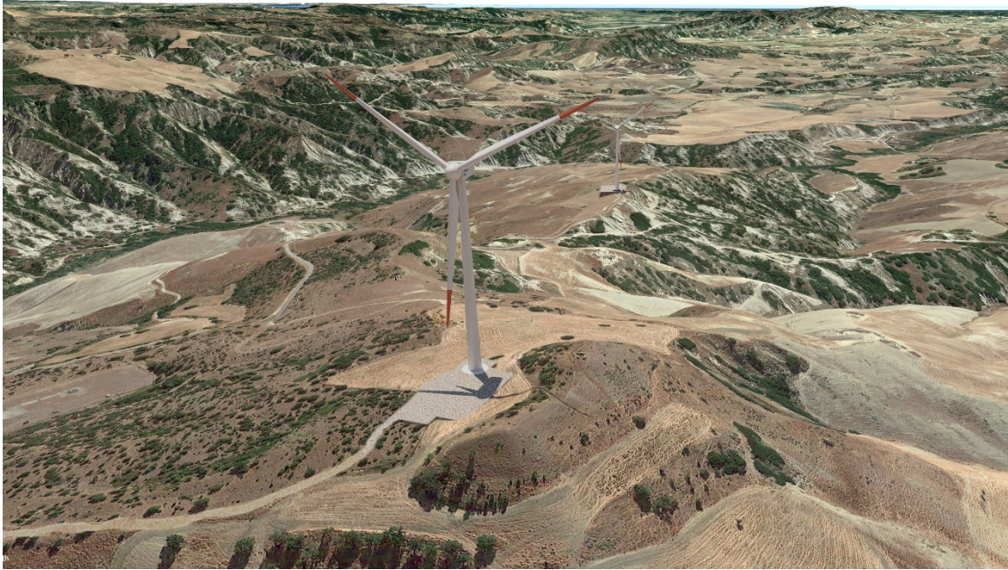
Figura 27: Vista degli aerogeneratori n.3 e n.5
