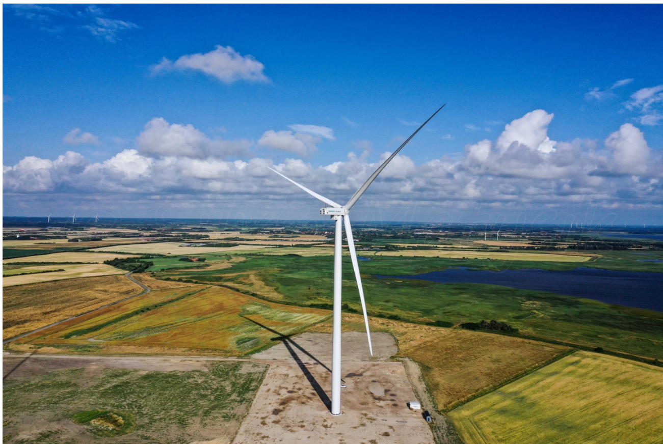
Figura 1: Esempio di turbina eolica Siemens Gamesa 6,20 Mw, D = 170 m e P =6,20 Mw
