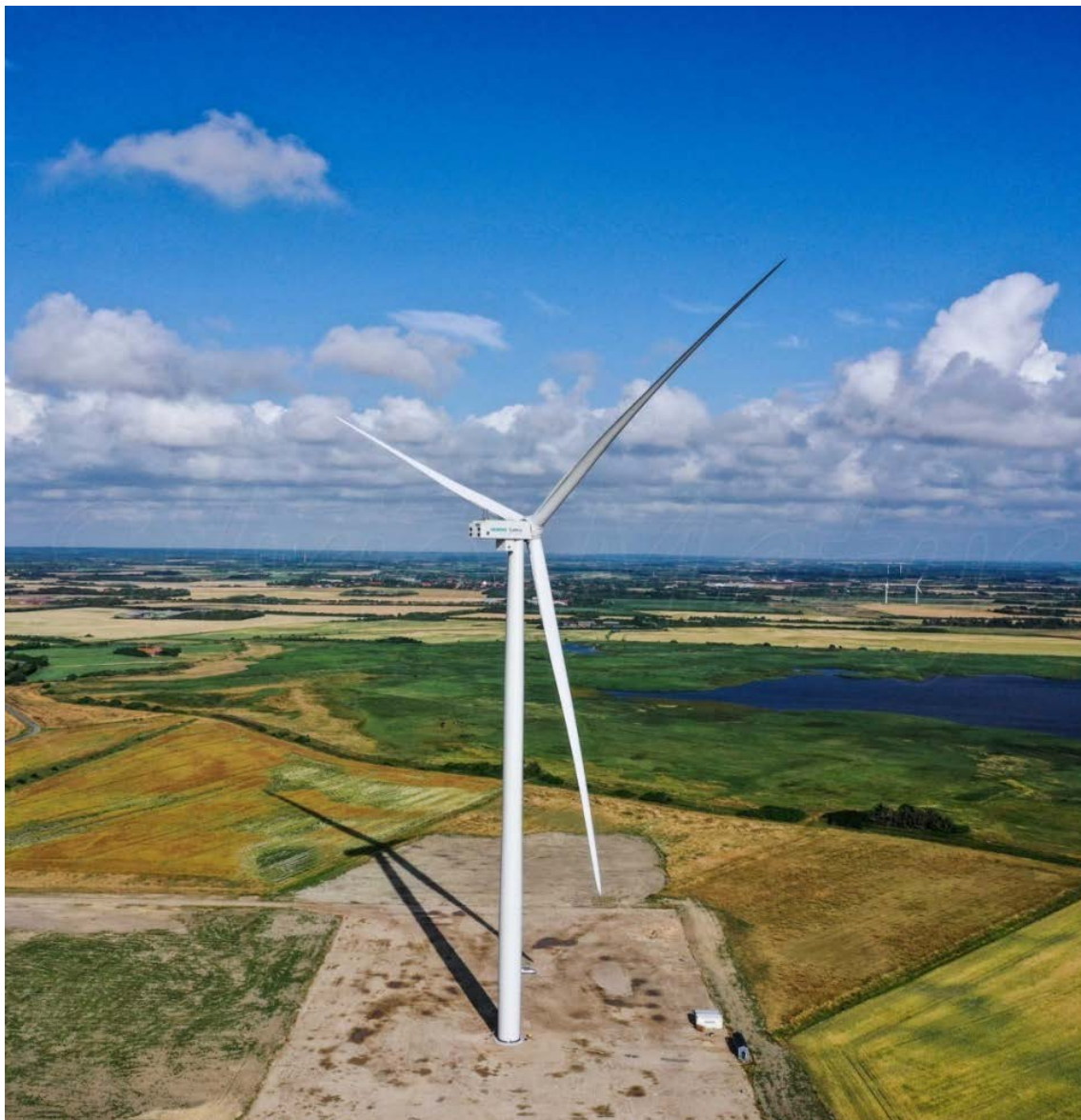
Figura 24: Turbina eolica Siemens Gamesa SG 6.2 - 170 con diametro rotore di 170 m ed altezza al mozzo di 115 m
