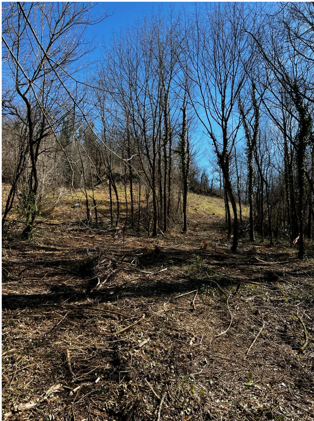
Figura 21: Pozzo 1 filare al centro dell'area di cantiere
