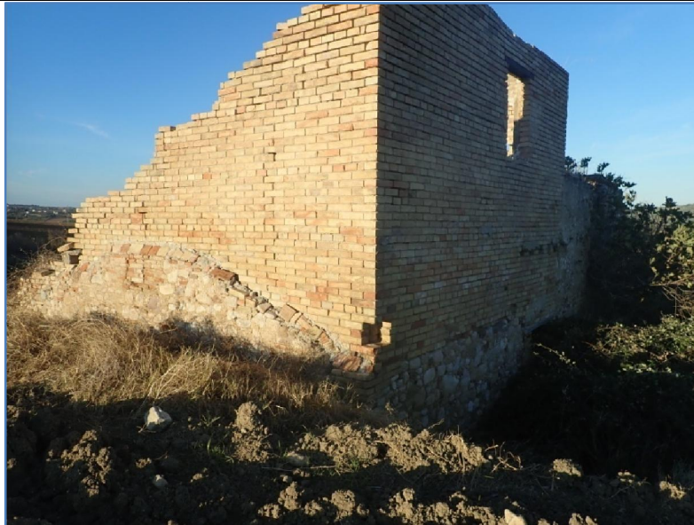
Casolare con tracce di murature apparentemente antiche alla base, posto sul colle.
