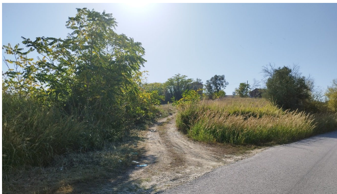
Viabilità esistente con pavimentazione naturale in pessimo stato
