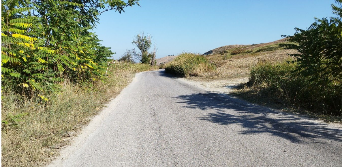
Viabilità esistente in conglomerato bituminoso in buono stato
