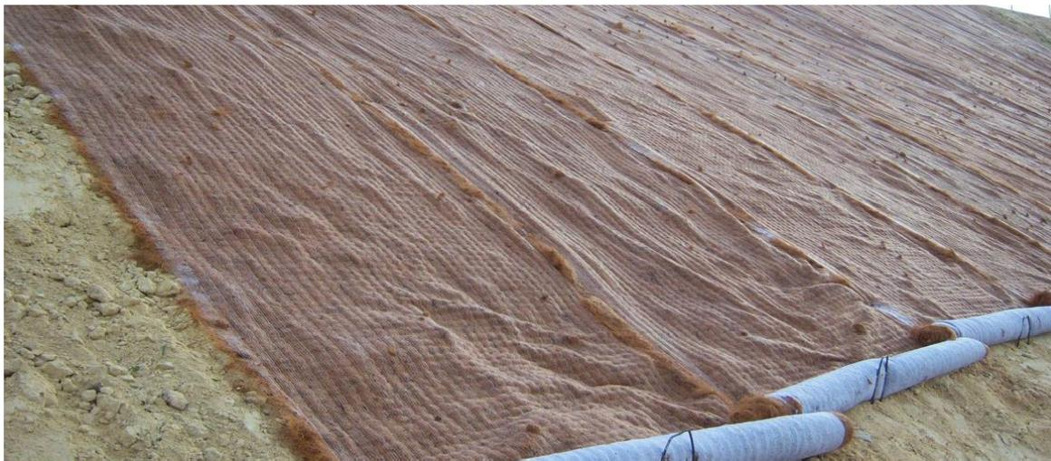
*Figura 25: Posa della biostuoia antierosiva in fibra di cocco e/o paglia*
