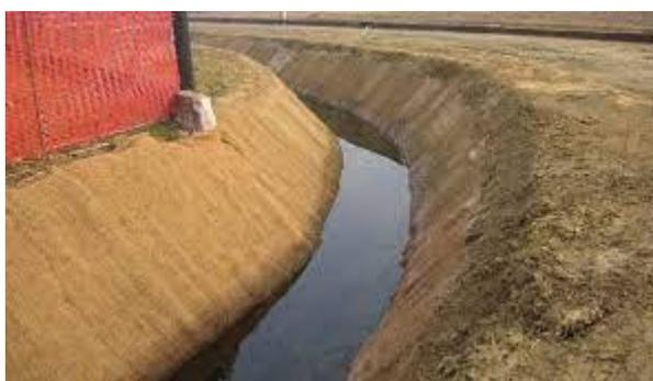
*Figura 26: Inserimento di stuoia biodegradabile sulle sponde dei canali*
