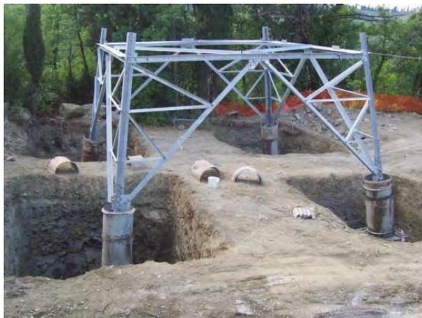
*Figura 39: Realizzazione di fondazioni superficiali tipo CR per sostegno a traliccio. Si possono osservare le quattro buche, la base del sostegno collegata alla fondazione tramite i "monconi" ed i casseri utilizzati per i quattro "colonnini"*
