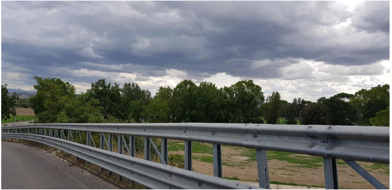
Vista 2 dal sovrappasso autostradale
