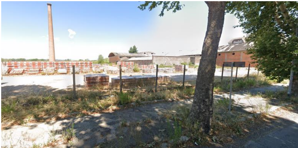
Figura 50 L'impianto della ex fornace Brizzi dalla Via Salaria
