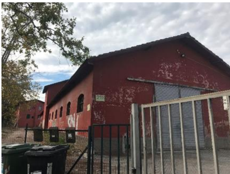
Figura 29 Insediamento rurale n. 1: Bene architettonico rurale, contraddistinto con sigla tpr_509 – Casale via Salaria (fonte: PTPR regione Lazio)
