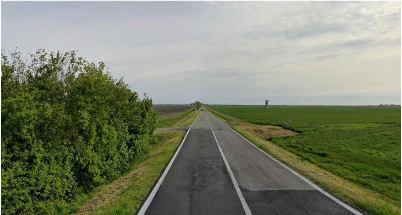
Figura 33 - Punto di vista 2 - Stato di fatto
