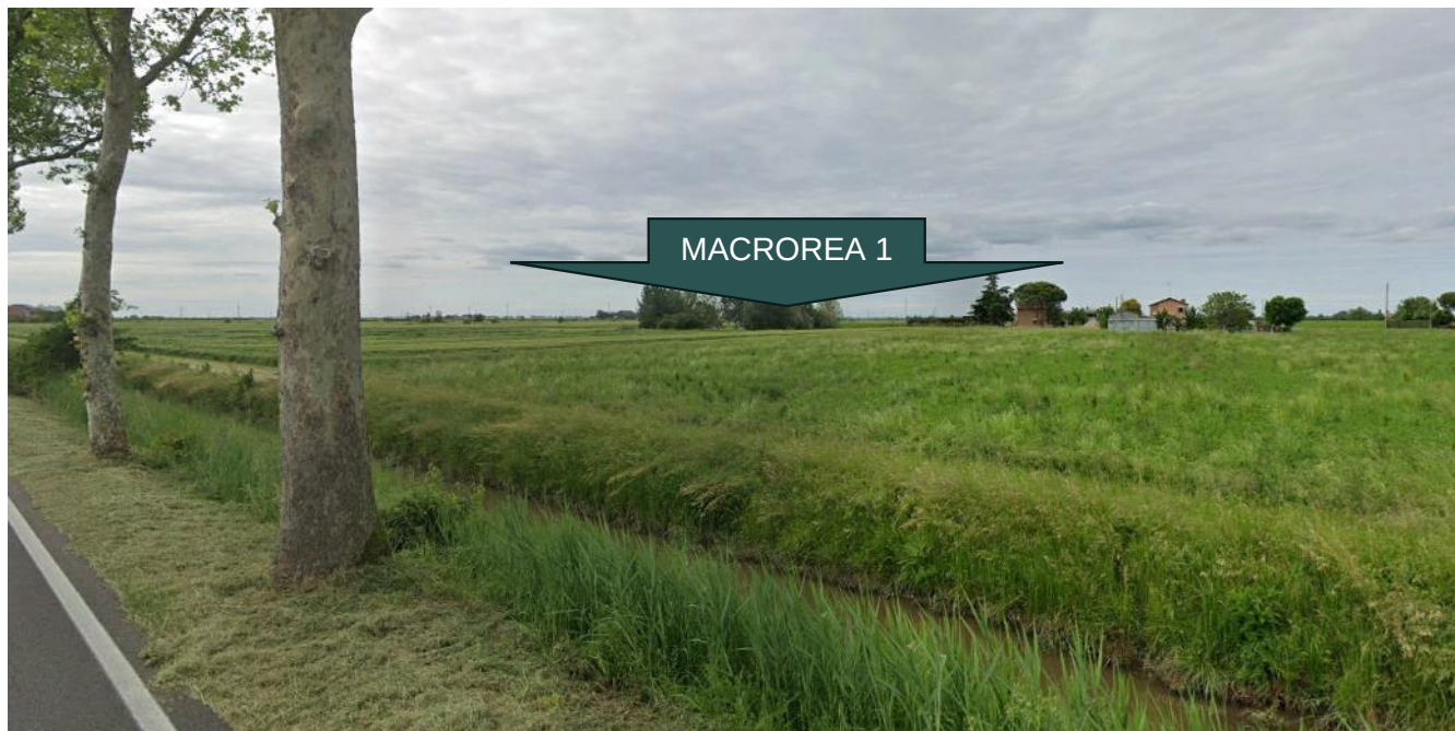
Figura 43 - Punto di vista 7- Stato di fatto
