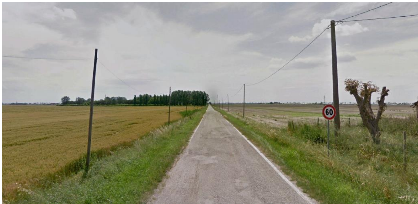
Figura 41 - Punto di vista 6- Stato di fatto
