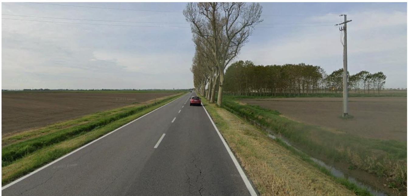
Figura 35 - Punto di vista 3 - Stato di fatto
