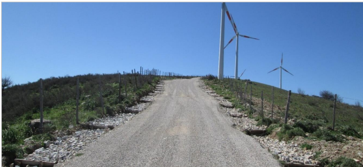
Figura 16 - Esempi di sistemi di fossi di guardia con fondo rivestito in pietrame e salti.
