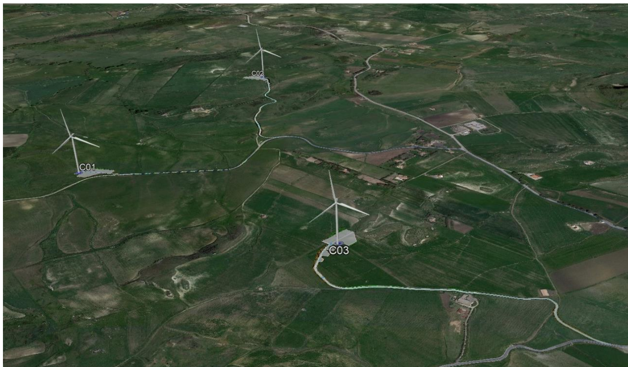
Figura 3 Aerogeneratori area a Nord - Comune di Caltavuturo
