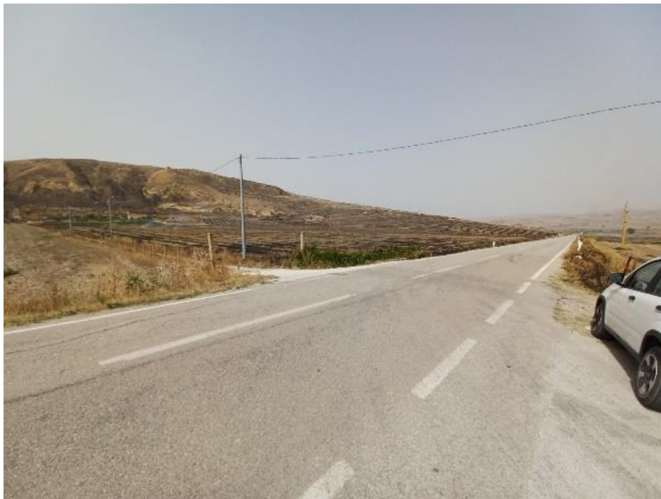
Figura 41 Cavidotto tra Parco Sud e stazione utenza, tratto finale lungo la SS121 presso area stazione di utenza.
