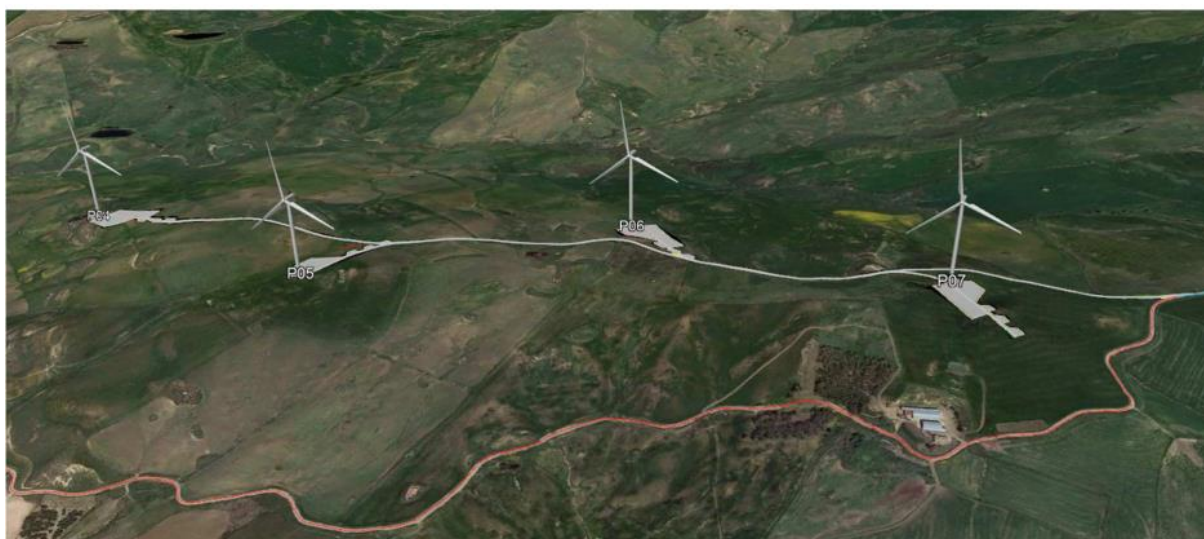
Figura 2 Localizzazione degli aerogeneratori da P05 a P07 ricadenti nel Comune di Polizzi Generosa (PA)
