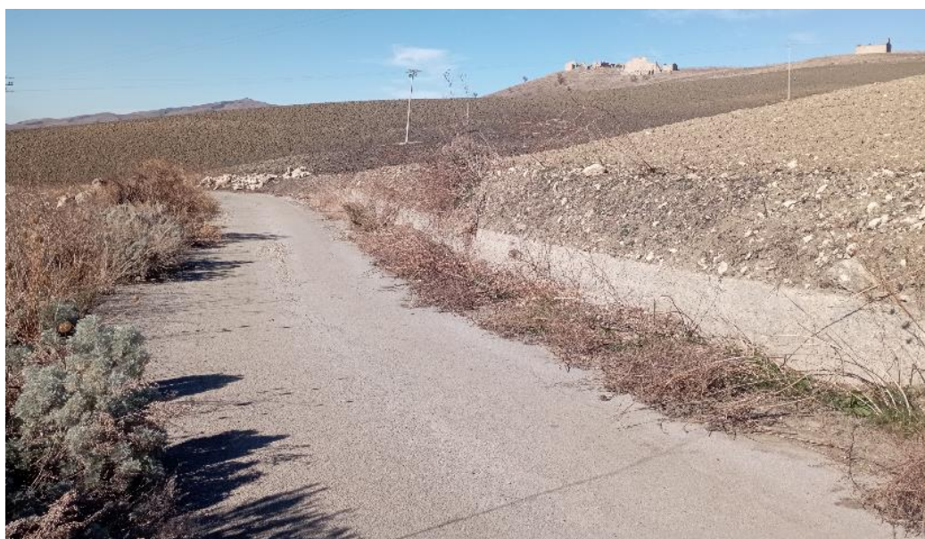
Figura 90 - Tracciato SP 64 verso P07, sullo sfondo il rudere con chiesetta
