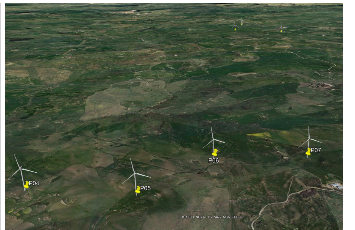
Figura 20 – Vista degli aerogeneratori in progetto
