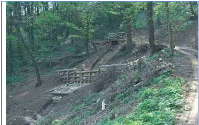
Figura 31 – Esempio di briglie in legname e pietrame - Fonte HE
