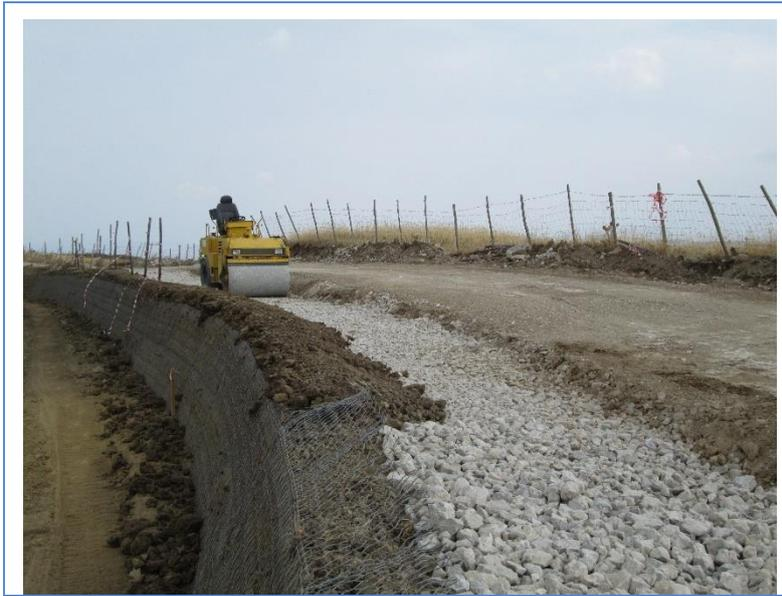
Figura 35 – Esempio di opera in terre rinforzate - Fonte HE
