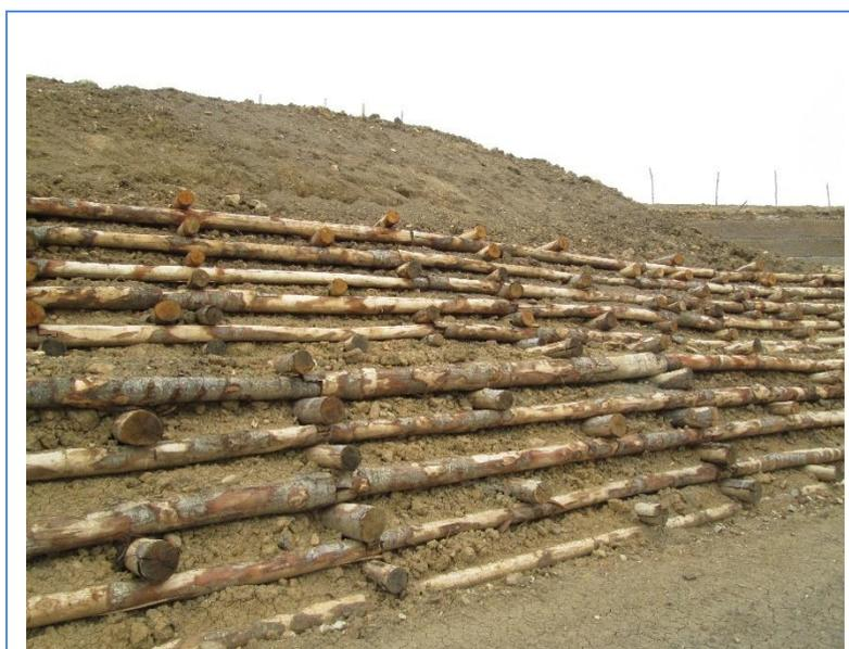
*Figura 34 – Esempio di opera in palificate in legname - Fonte HE*
