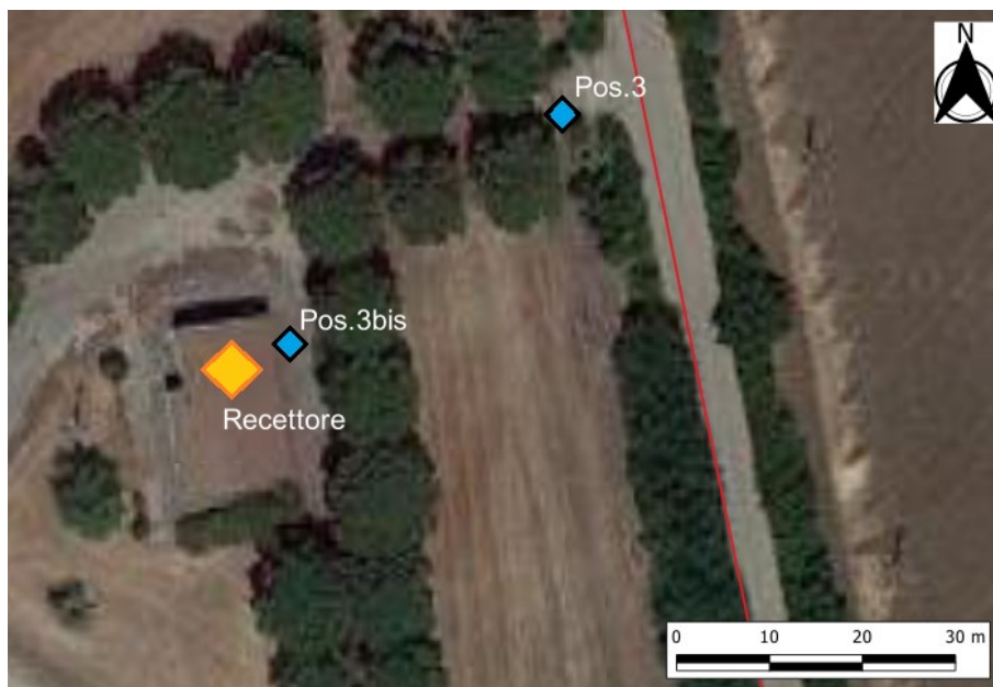
Figura 4-11: Dettaglio del recettore rumore ubicato lungo il cavidotto
