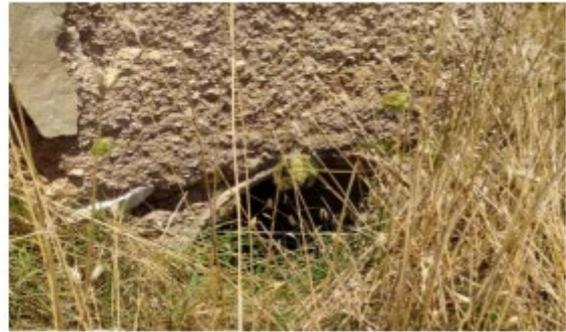
**Figura 20 - Foto da sopralluogo rappresentanti l'andamento pianeggiante dei terreni e il grado di occlusione dei manufatti di attraversamento**
