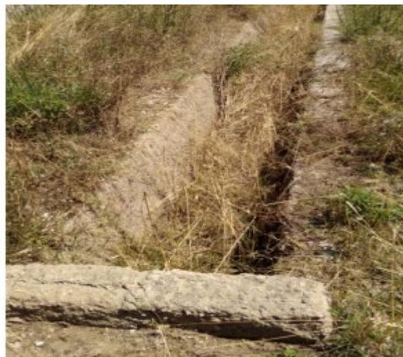
**Figura 22 - Inerbimento fosso e attraversamento idraulico in corrispondenza di un accesso**
