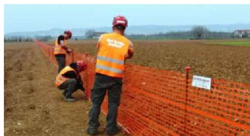
Per le aree di cantiere lungo strada attiva, soggetto ad una occupazione limitata nel tempo, dovranno essere adottati provvedimenti che seguano l'andamento dei lavori e che comprendano, a seconda dei casi, mezzi materiali di segregazione e segnalazione oppure uomini con funzione di segnalatori o sorveglianti.
