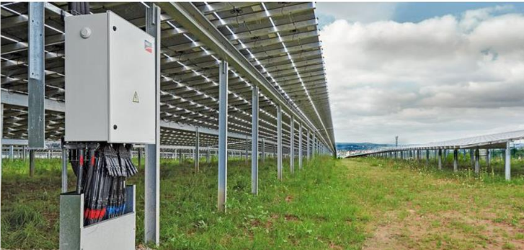
Figura 5 - Esempio di string combiner SMA
