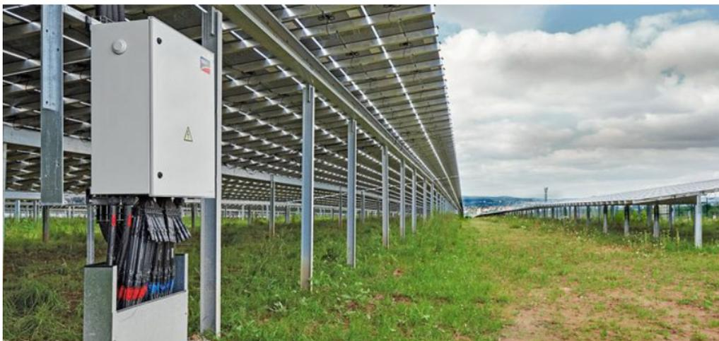
Figura 5 - Esempio di string combiner SMA
