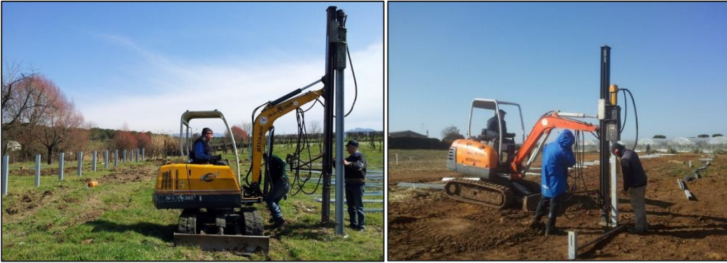
Figura 55 - Tipologia di installazione delle strutture di sostegno dei moduli FV con macchina battipalo
