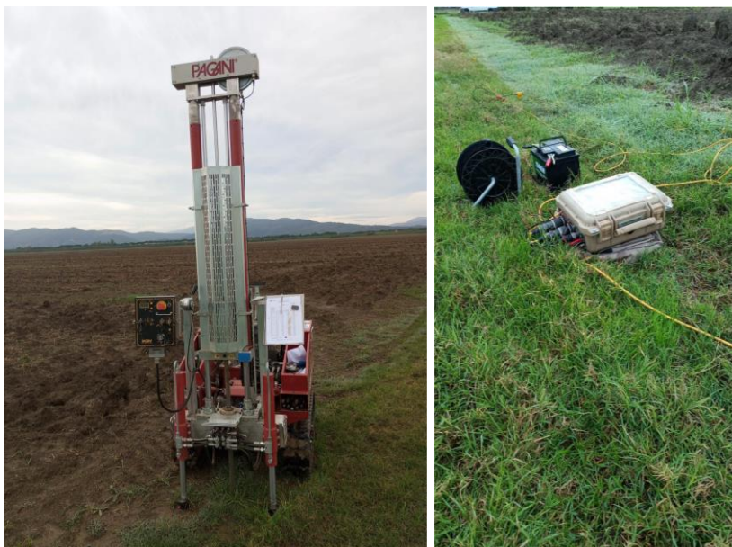
Figura 86 - Indagini geologiche e geognostiche in sito
